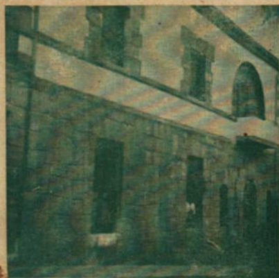
Vista exterior de las Oficinas de Mengibar
