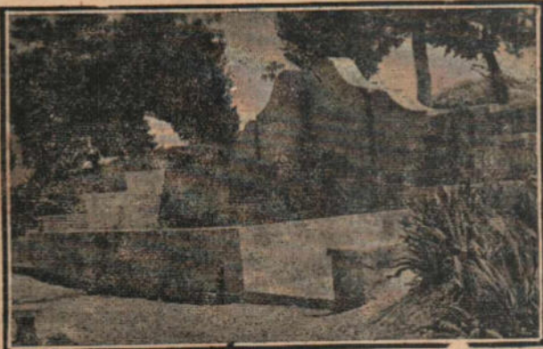
Estanque del Parque Municipal, al que se ha llevado el agua recientemente mediante obras de captación subvencionadas por la Junta Provincial del Paro.
