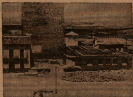
Estado de las obras del nuevo Ayuntamiento—hoy aún más avanzadas—a que se hace referencia en este artículo
