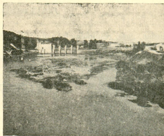
Mengíbar (Jaén). Central hidroeléctrica sobre el río Guadalquivir
