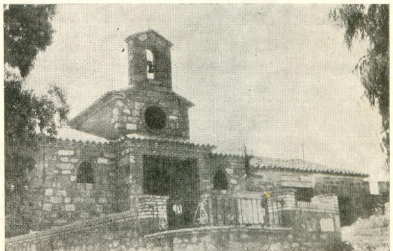
Ermita del Santísimo Cristo de las Lluvias, que ha sido reconstruida por el Ayunt., al realizar las obras de mejora, ampliación y accesos del Cementerio Municipal.
