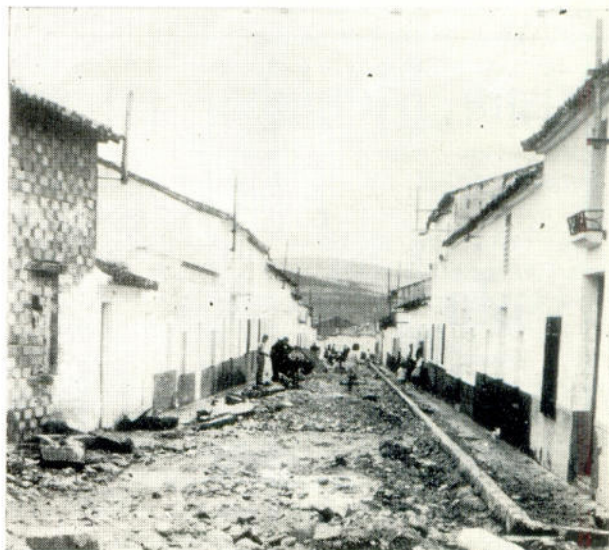
Actual situación de las obras, que han dado comienzo en la calle José Torres Martínez.
