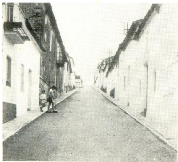
Vista de la calle General Mola, con su nueva pavimentación.
