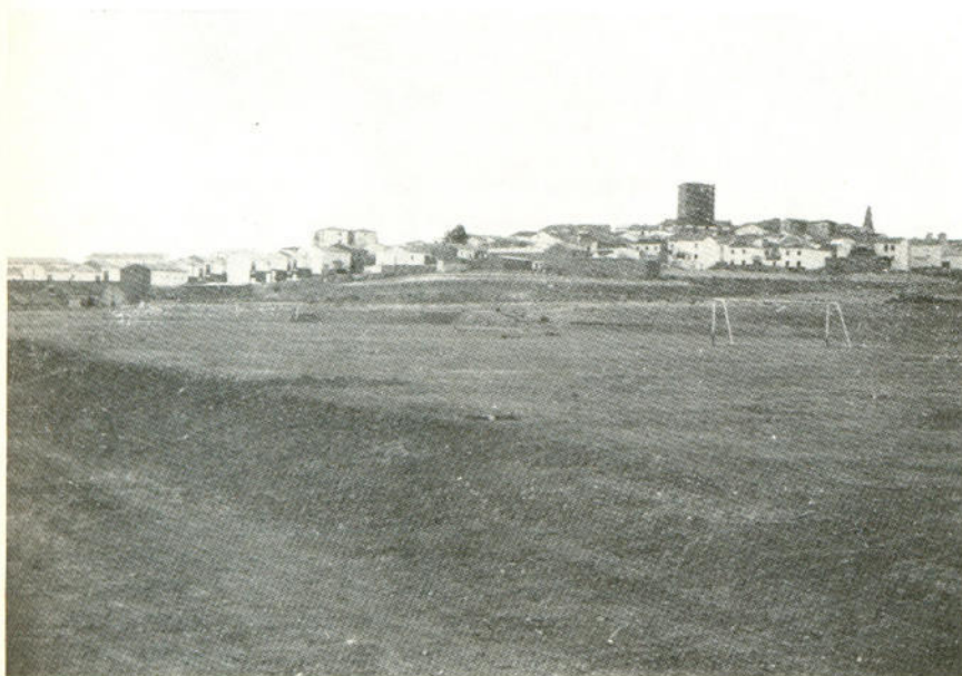
Estado de las obras para la construcción del tan "deseado" Campo de Fútbol con Pistas Polideportivas y Piscinas Olímpicas en Fuente Redonda.
