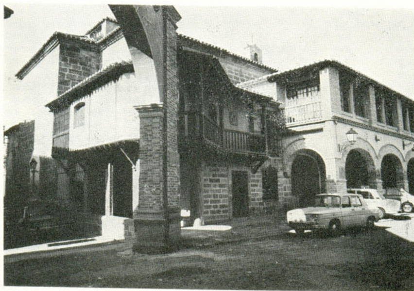
Bello rincón de la Plaza del Caudillo, con la Casa Parroquial, Sacristía y soportales.
