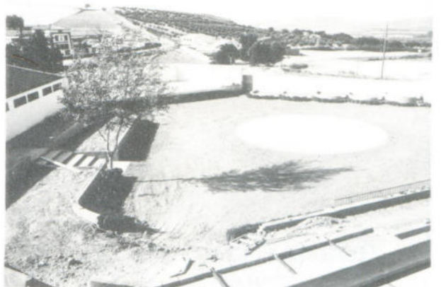
Obras de reforma en la Piscina Municipal.
