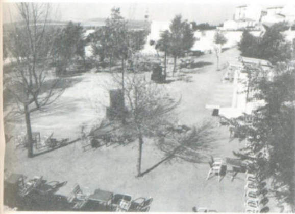
Obras de reforma en la Piscina Municipal.
