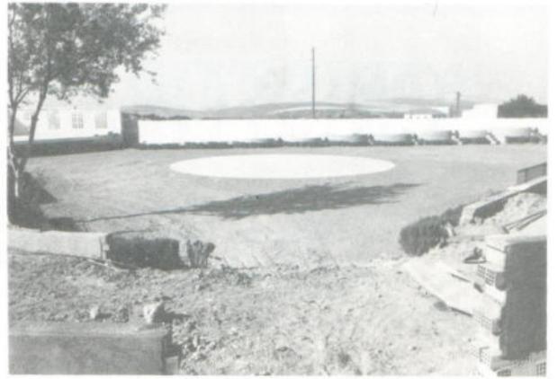
Obras de reforma en la Piscina Municipal.
