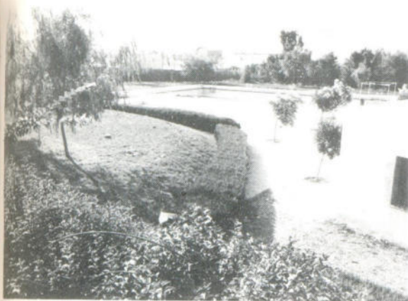
Obras de reforma en la Piscina Municipal.
