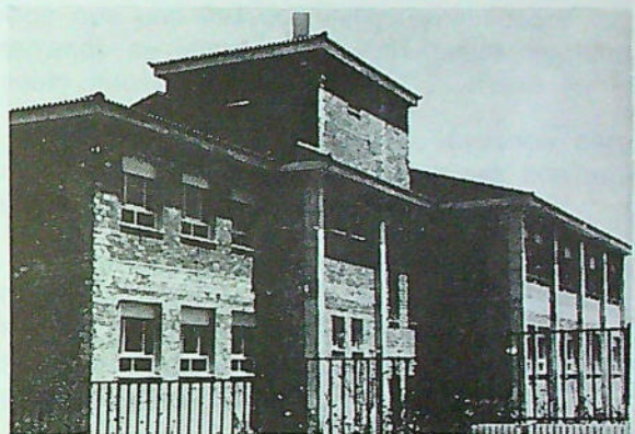
Construcción del nuevo módulo de B.U.P. dentro del recinto de F. Profesional.
