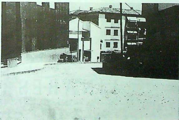
Obras en calle Real.
