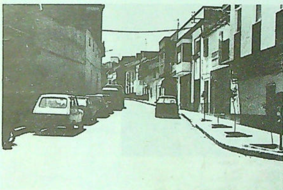
Pavimentación y aceras de la calle Manuel de la Chica.
