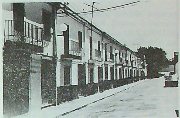
Nuevo alumbrado del grupo de «72 Viviendas».
