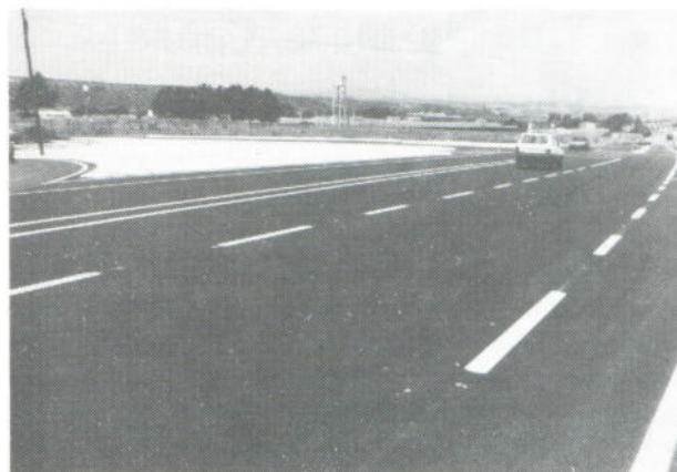
Nueva señalización e isletas en el cruce entre la carretera nacional 323 y la comarca Mengíbar-Villargordo.
