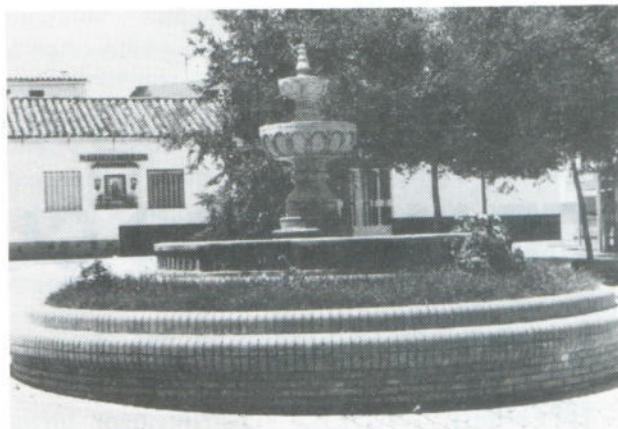
Construcción de una artística fuente en la Plaza de Santa María Magdalena.
