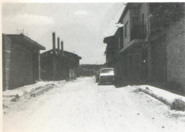
Primera fase de pavimentación y construcción de aceras en la paralela a la calle Gustavo Adolfo Bécquer.
