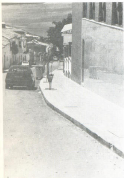
Remodelación de las aceras en la Avenida Reina Sofía, previa instalación de una nueva línea de agua potable.
