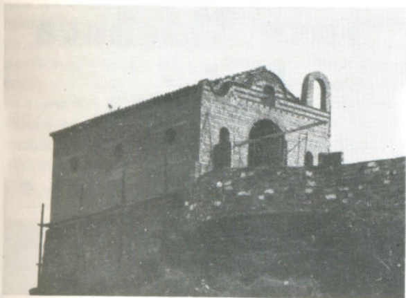
Construcción, en fase muy avanzada, de la nueva ermita de Santa María Magdalena.
