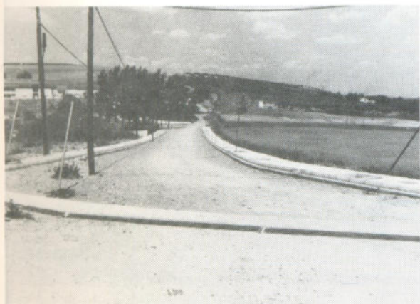
Nuevo trazado, pavimentación y aceras del paraje de «Fuente Redonda».
