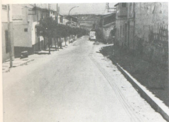
Colocación de bordillos y aceras como primera parte de la segunda fase en la nueva pavimentación de la c/ Real.
