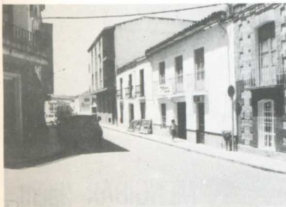
Pavimentación de la calle Alfonso XIII
