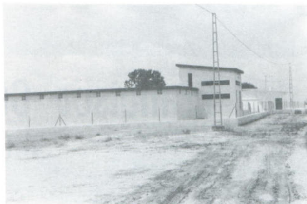
Nuevo Depósito de Agua.
