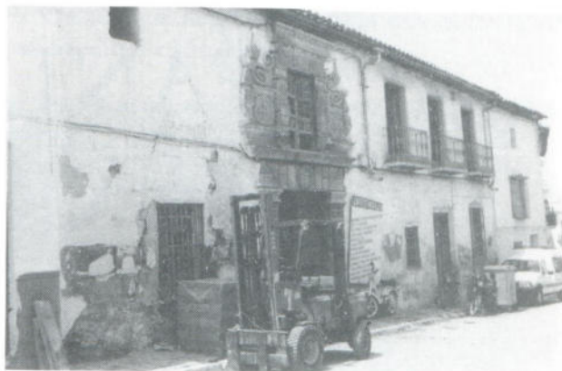
Rehabilitación Casa de la Inquisición.
