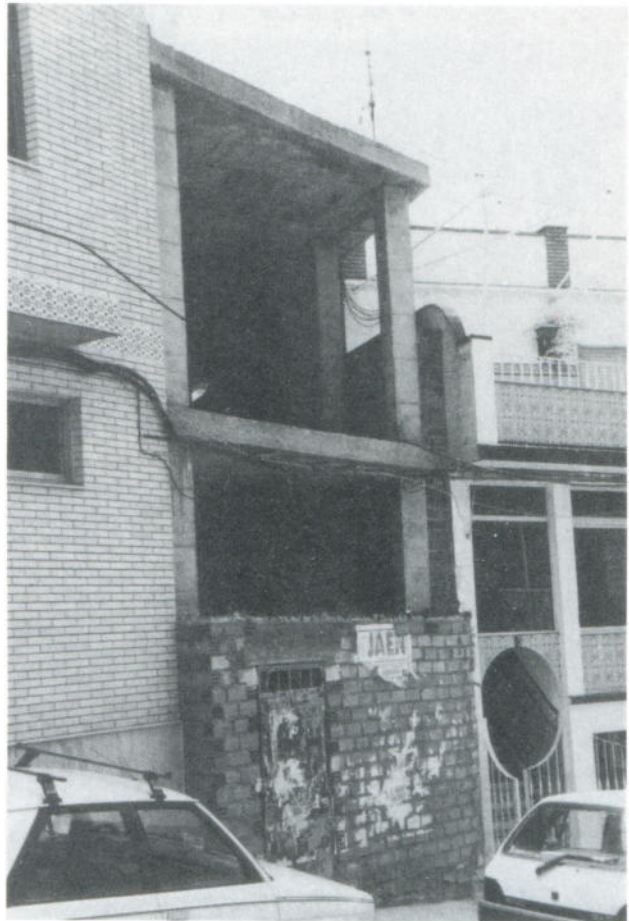
Centro de Día. (Fachada a Avda. Reina Sofía).
