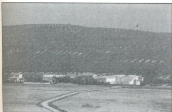
Panorámica de la estación
