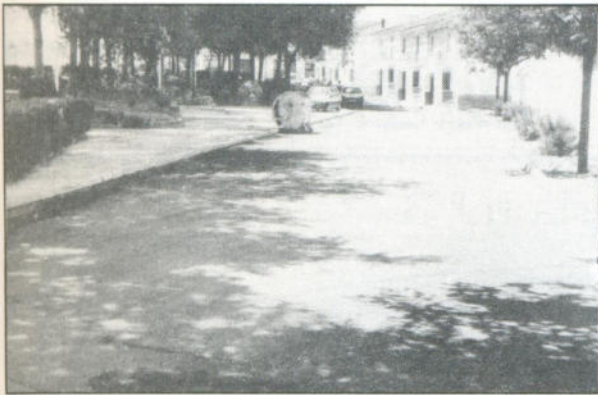
Pavimentación Calle Bailén. 72 viviendas.
