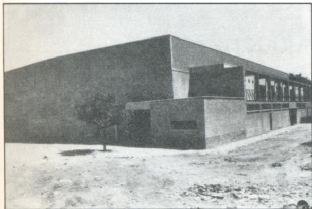
Pabellón Deportivo Cubierto.
