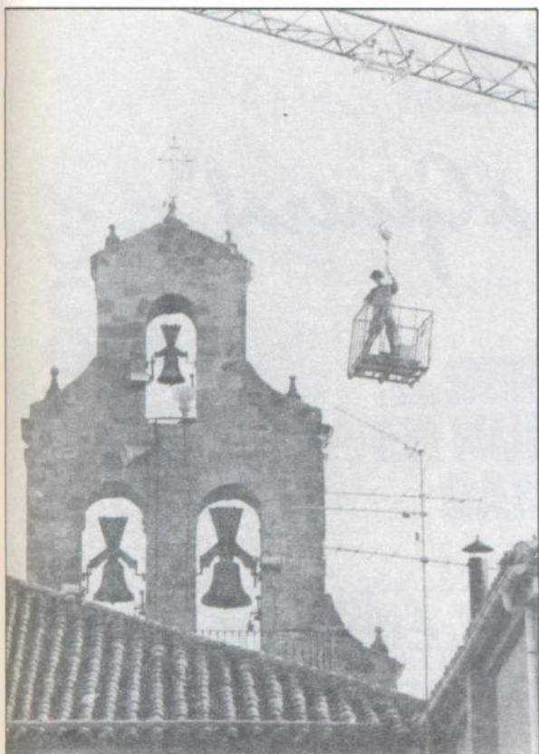
Instalación de las antiguas campanas de volteo automático.
