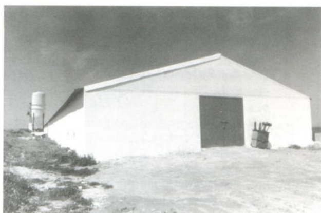
Reparación Nave de disminuidos.
