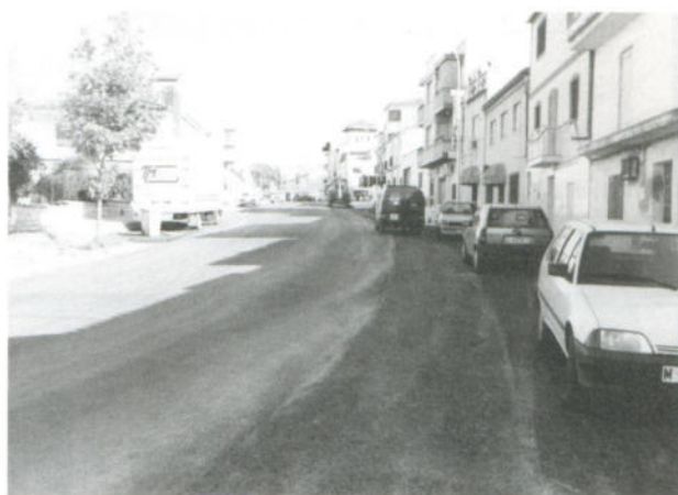
C/. Bailén (Zona baja). Pavimentación.
