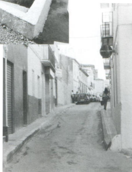
Reparación bordillos y aceras C/. Queipo de Llano.
