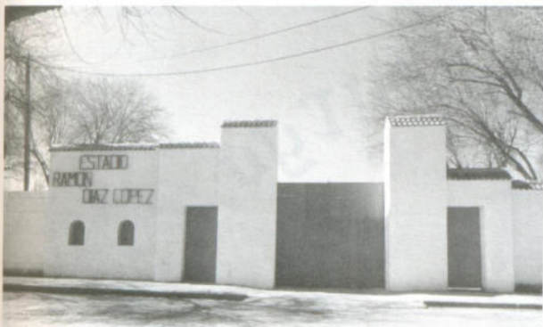
Reparación entrada Campo de Fútbol.
