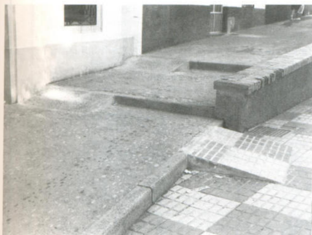
Plaza de la Libertad. Eliminación de barreras arquitectónicas.
