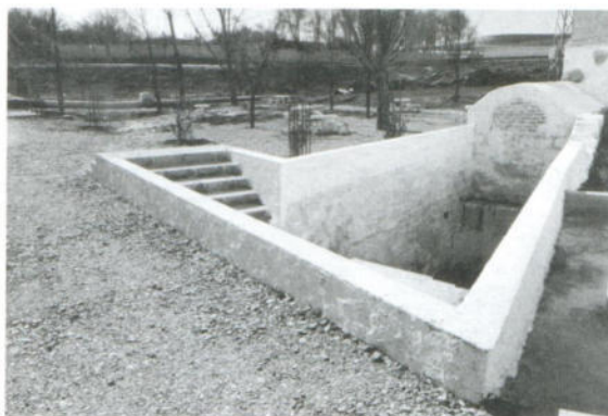
Reparación Fuente Redonda.
