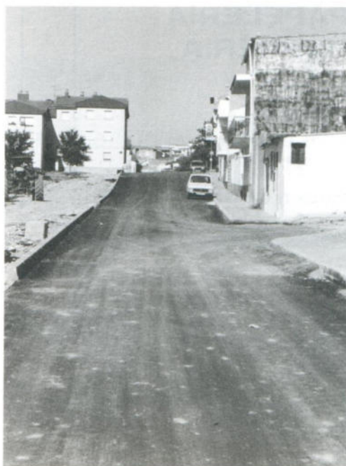
Pavimentación C/. Guadalbulbón.
