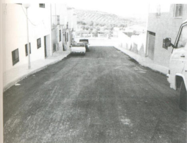
C/. Huelva. Pavimentación.
