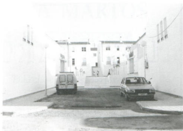
Nuevas viviendas Auto-construcción. Pavimentación.
