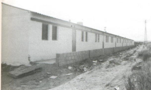
Reparación Nave de Disminuidos.
