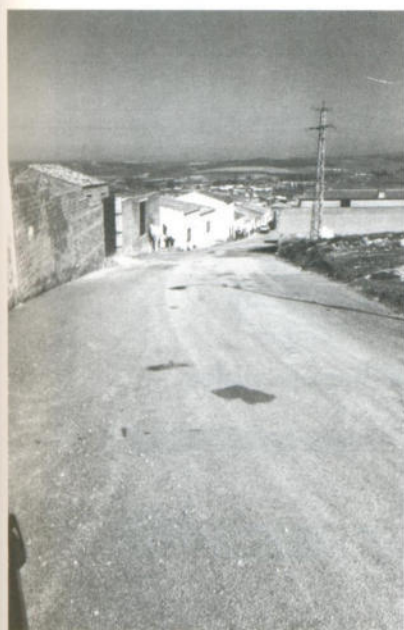
Pavimentación C/. Señor de las Lluvias.
