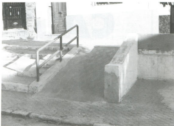
C/. Pozuelo - Eliminación de barreras arquitectónicas.
