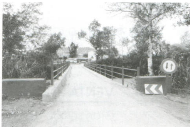
Reparación del puente de la Ctra. de Villargordo.
