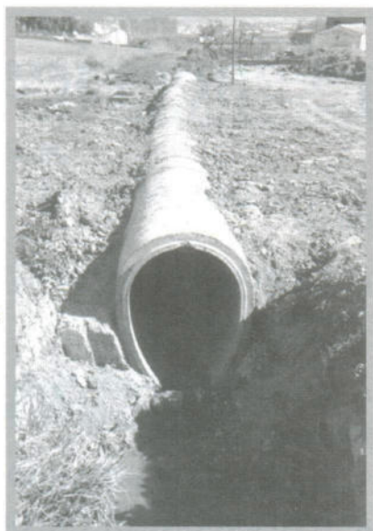
Canalización Arroyo del Matadero.
