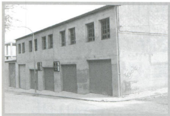
Nuevas oficinas y almacenes Casa de Oficios.
