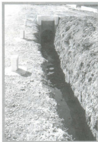
Canalización Redonda de la Tejera.
