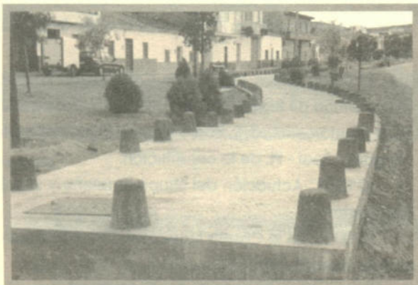
Refuerzo del Canal
