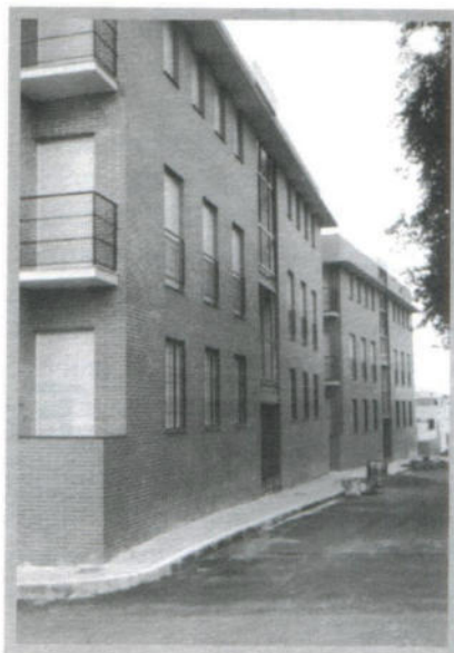
12 viviendas de Autoconstrucción
