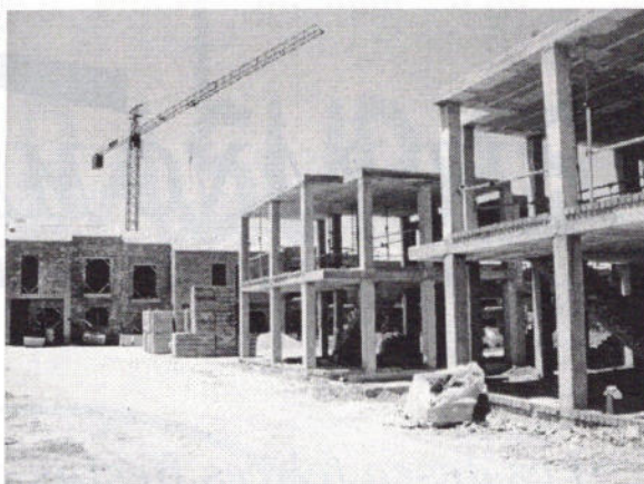
Construcción 66 viviendas antigua Ctra. Bailén-Motril.
