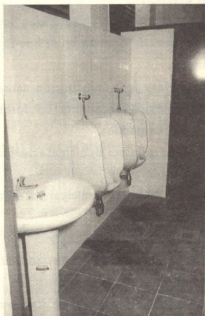
Construcción de Servicios Campo de Futbol
