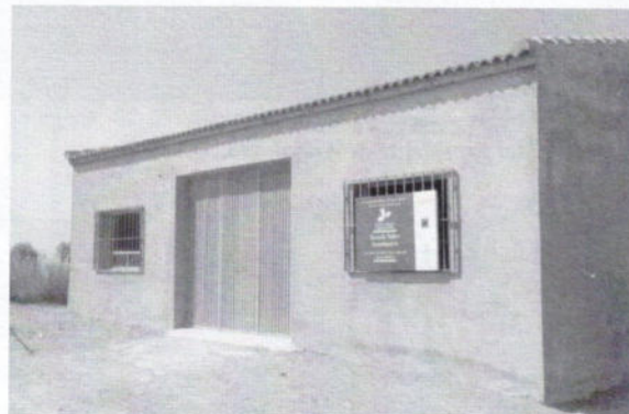
Construcción de nave por la Escuela Taller.
