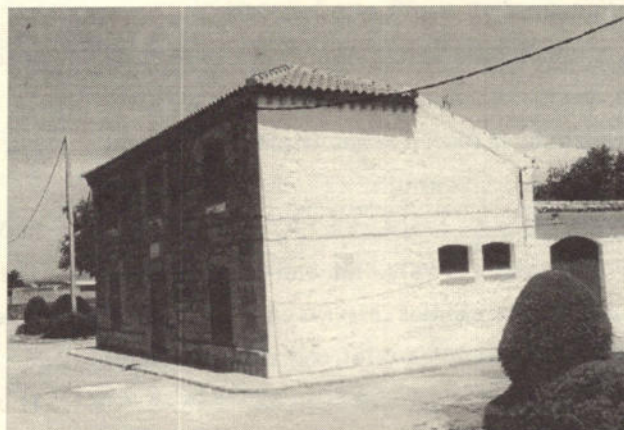
Reformas en Matadero Municipal
