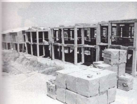
Construcción 66 viviendas antigua Ctra. Bailén-Motril.
