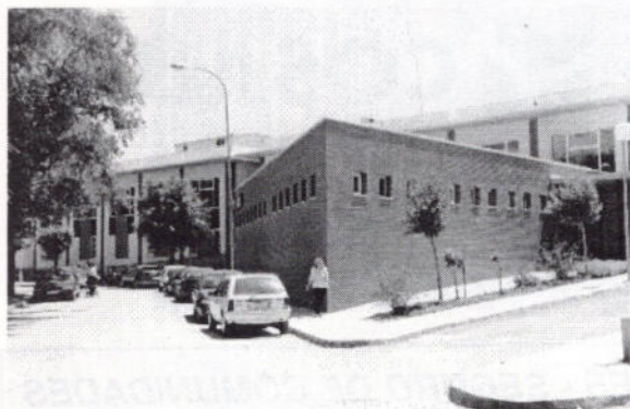
Puesta en funcionamiento Centro de Salud.
