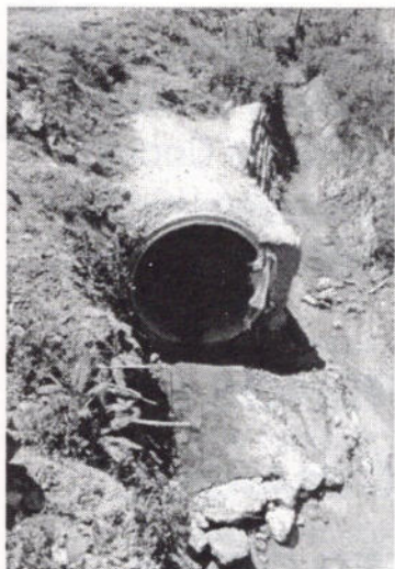
Canalización de arroyo c/. Redonda de la Zejera.
