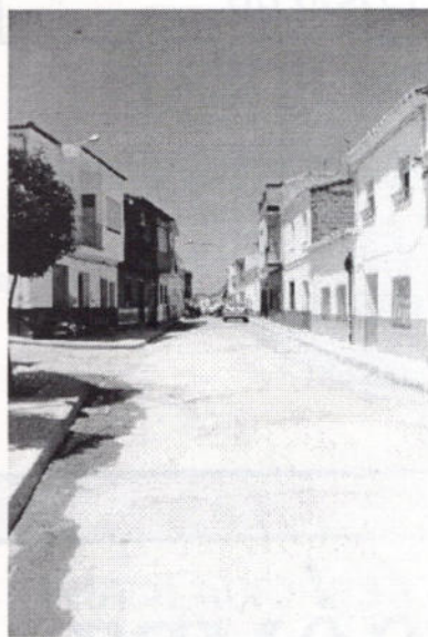
Pavimentación c/ José Torres Martínez
