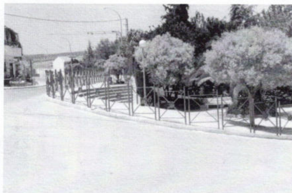
Señalización de viales y protección peatonal.
