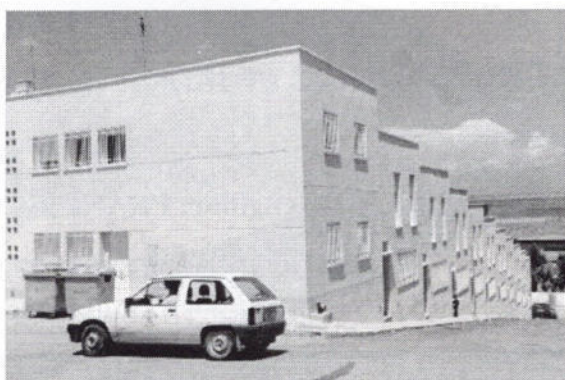
Asfalto en viales 56 viviendas.
