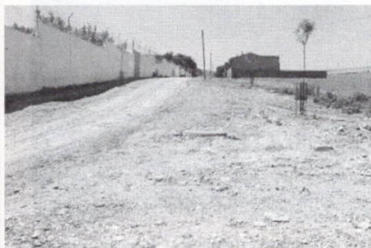
Canalización de arroyo c/. Redonda de la Zejera.
