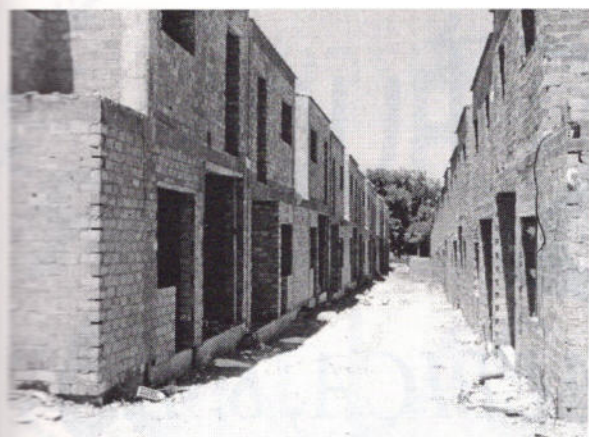
Construcción 66 viviendas antigua Ctra. Bailén-Motril.
