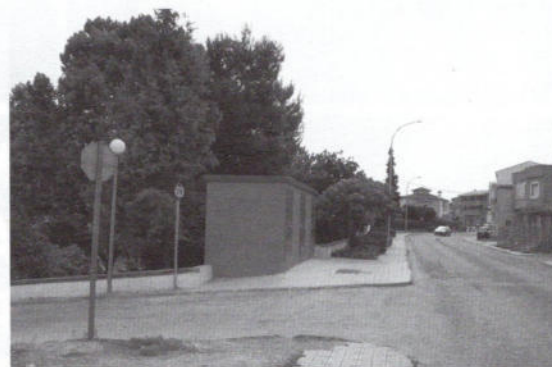
Mejora de red eléctrica para dar servicio a la zona del Parque Municipal por importe de 24.500 €
