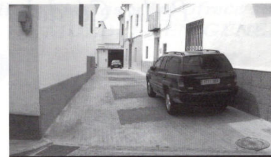
Estado actual de la calle Calatrava tras su remodelación
