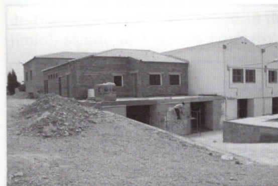
Construcción de naves en los almacenes municipales con fondos propios por importe de 52.340 €
