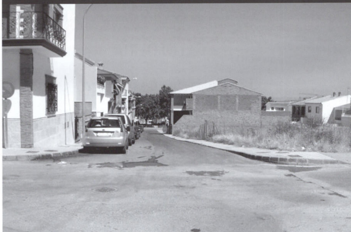
Pavimentación Calle Luis de Góngora
