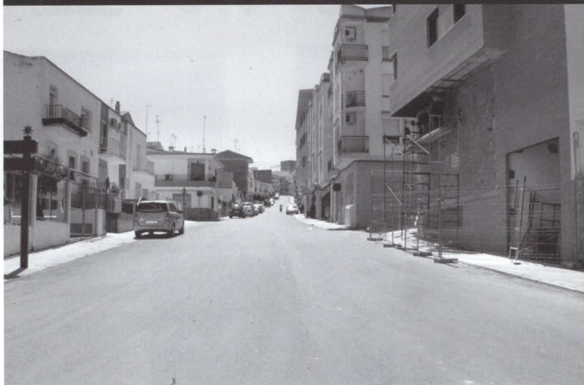
Pavimentación Calle Reina Sofía
