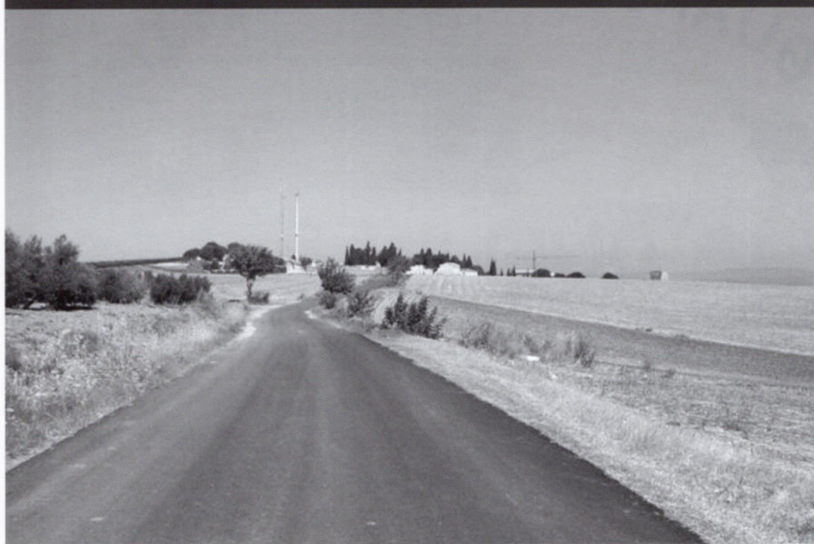
Pavimentación Carretera del Cementerio
