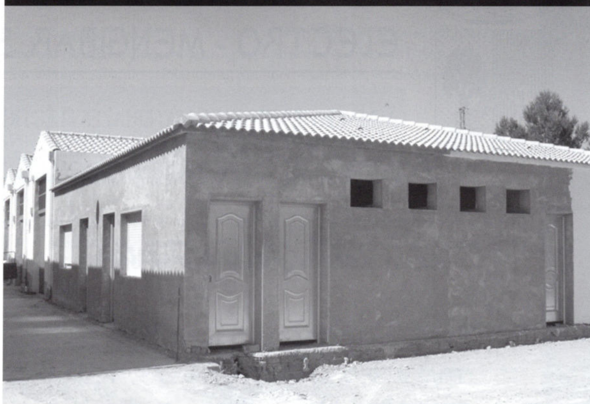
Comedor, vestuarios y servicios Almacén de Obras. PFEA 2006
