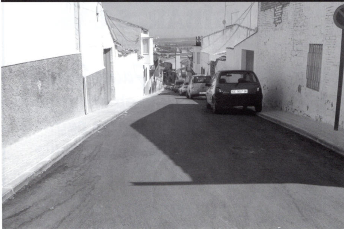
Pavimentación Calle Cervantes. Plan Operativo Local 2006
