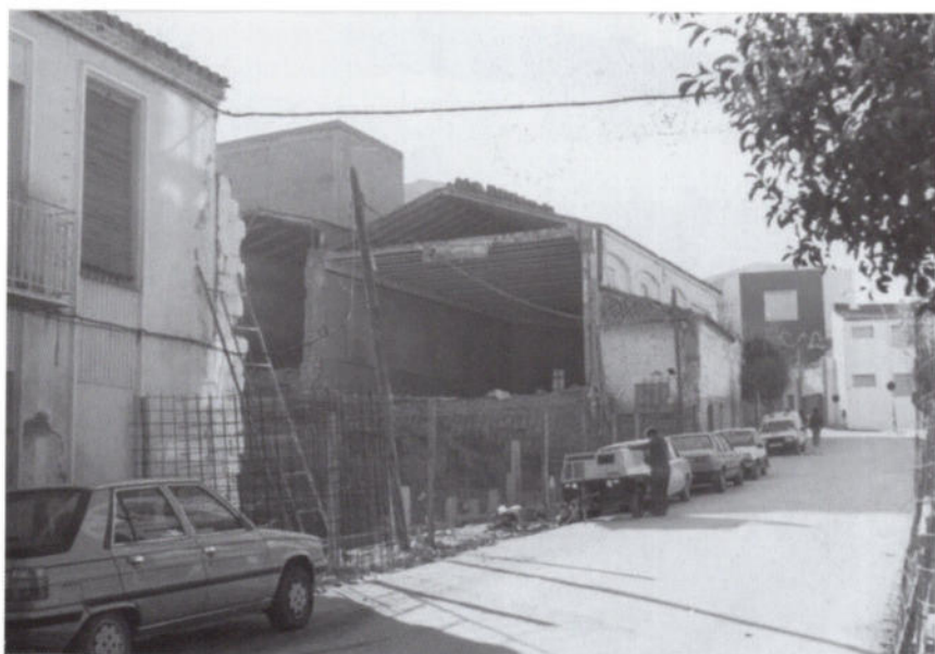
El cine «Capitol» de invierno, cuando fue demolido, en la calle «Real».
