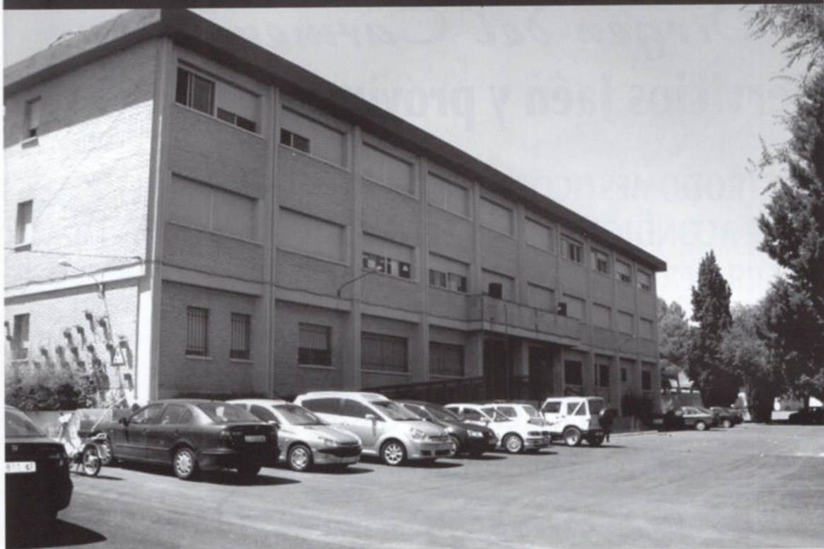
Colegio Santa María Magdalena. Reformas y Pavimentación
