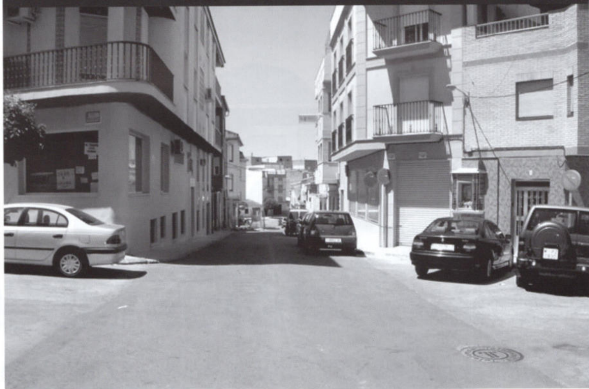
Pavimentación Calle Andújar
