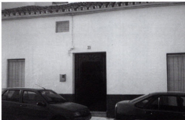
Casa, hoy propiedad de Juan Serrano Gómez, en la calle «Corredera», donde estuvo el «Cine Barranco»
