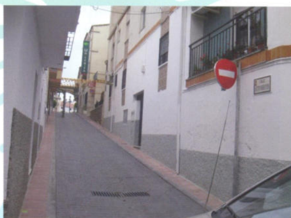
C/ Doctor Navarro Funes. Pavimentación, Acerados y Servicios
