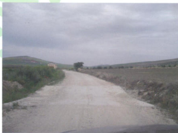
Camino Arjona - Construcción Vado inundable.
