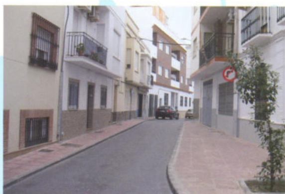
C/ Maestro Francisco Hortal - Pavimentación, Acerados y Servicios
