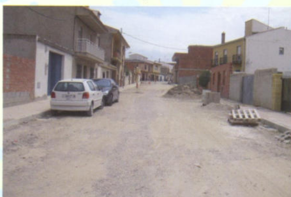
C/ Arjona - Pavimentación, Acerados y Servicios
