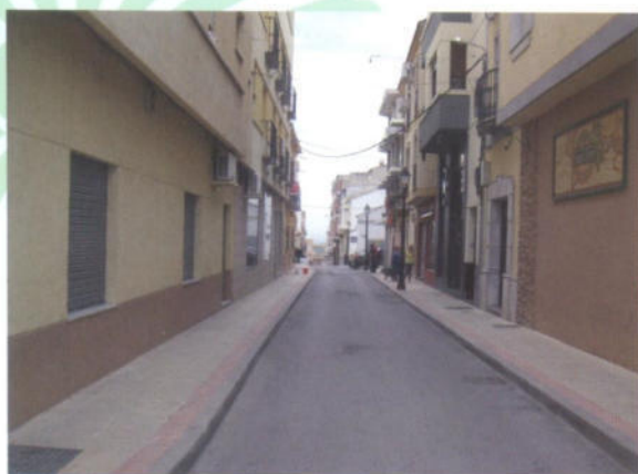
C/ Ruiz de Alda. Pavimentación, Acerados y Servicios.
