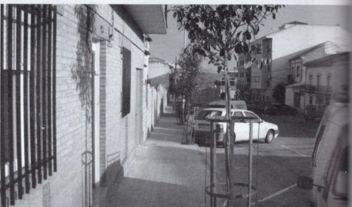
Calle Bailén - Renovación de Aceras y plantación de árboles
