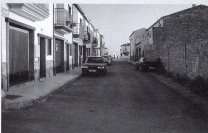
Calle Uva - Asfaltado
