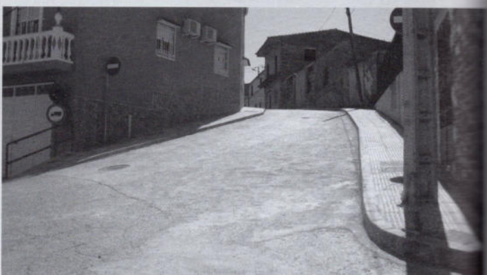
Calle Ana Cano - Remodelación Integral de Pavimento, Aceras, Servicios y Alumbrado
