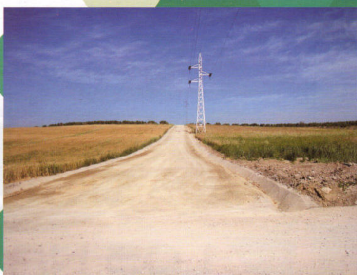
Camino Santa María Magdalena. Nuevo Camino que une el de las Aljonderas con el de Matacas
