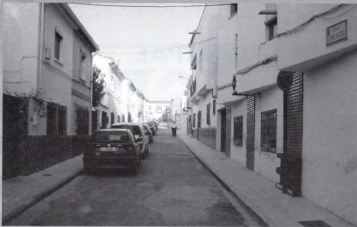
Calle General Moscardó Renovación de Acerados y Bordillos
