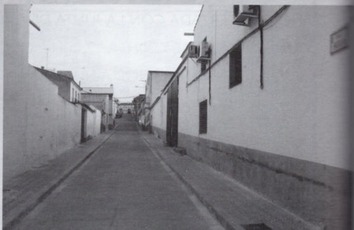
Calle Agua - Pavimentación y Acerados
