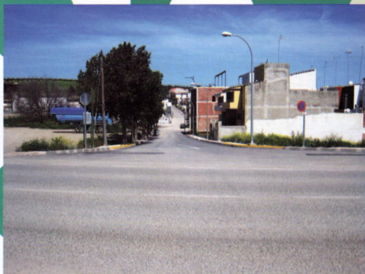
Calle Fuente Redonda Pavimentación y Acerados
