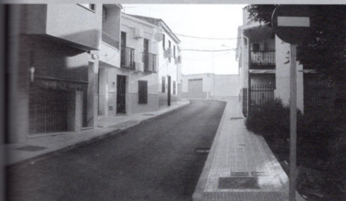
Calle Victoria Eugenia Remodelación Integral Acerados Pavimento y Servicios
