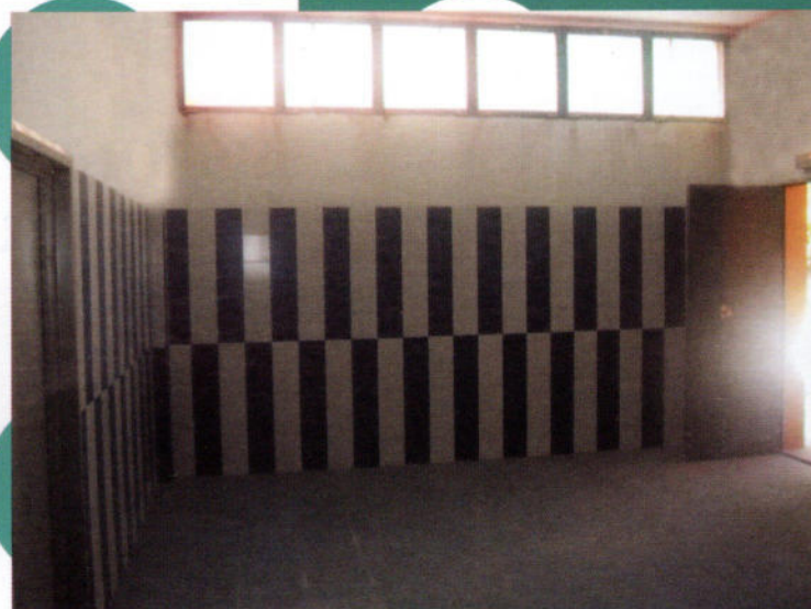
Reformas de los Vestuarios del Pabellón Sebastián Moya
