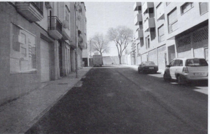
Asfaltado Calle Francisco López
