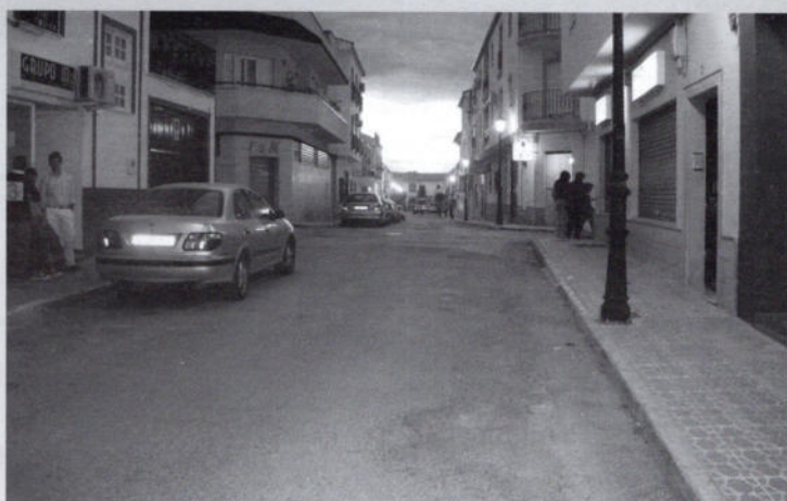
Calle Sevilla - Nueva Iluminación
