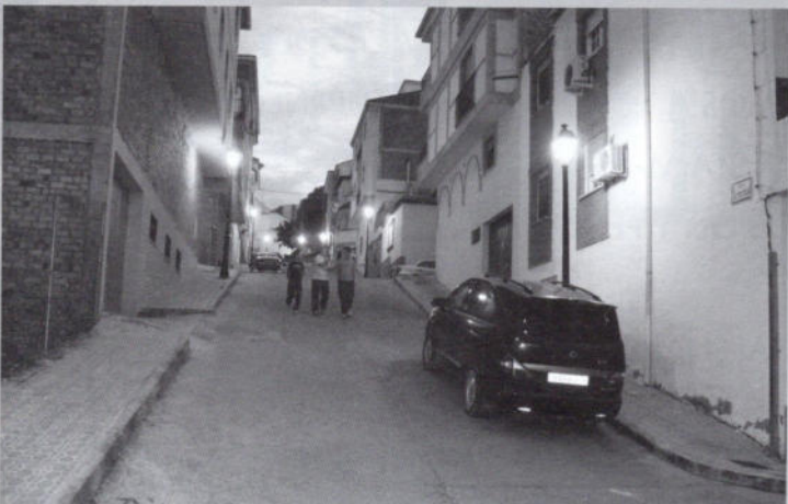
Calle Almería - Nueva Iluminación
