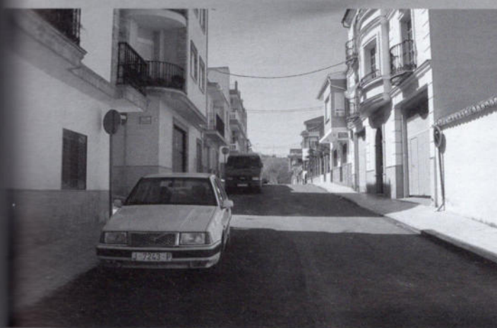
Asfaltado Calle Marqués de la Ensenada
