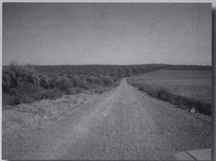
Renovación Camino de la Hoya
