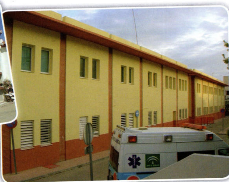
Pintura de Centro de Salud. Exterior e Interior.
