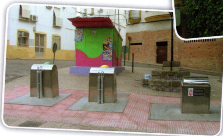
Soterramiento contenedores Plaza de la Libertad.
