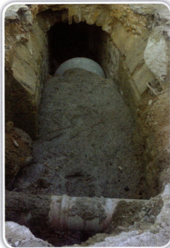
Mejora de saneamiento general en el cruce de la venta.
