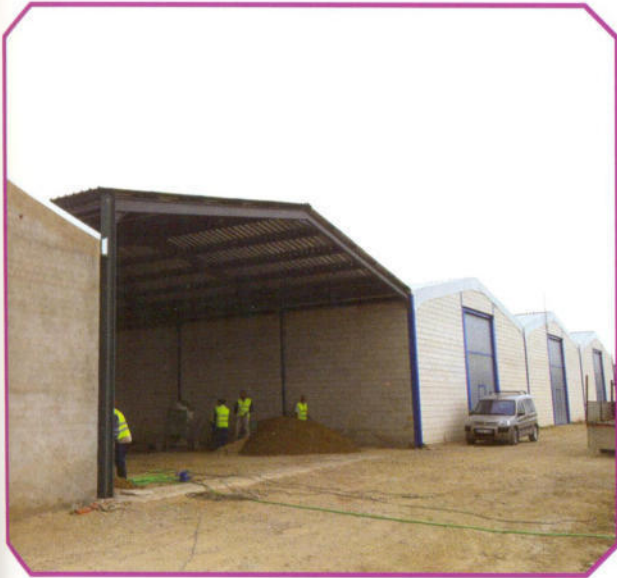
Nave almacenes municipales
