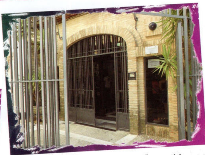
Instalación de Puerta Automática en el Ayuntamiento
