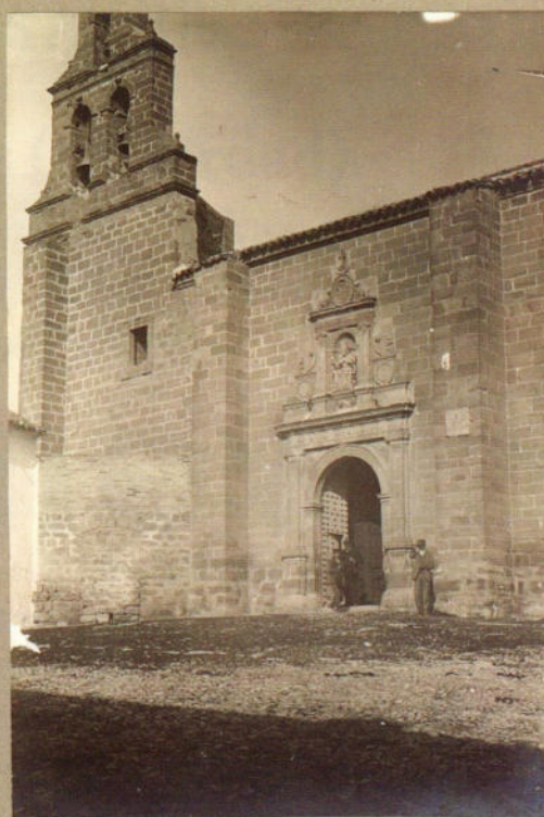
Vista de la Iglesia No. 406.
