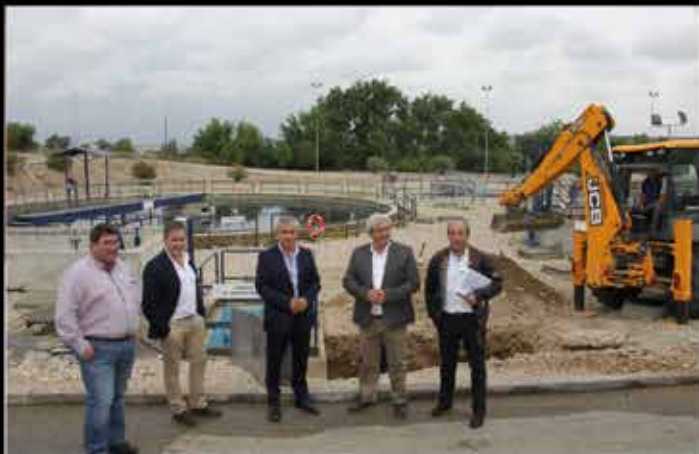
Obras en la depuradora para optimizar recursos
