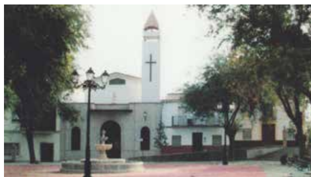
Estado actual de la fachada de La Inmaculada
