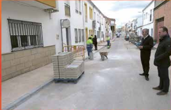
Nuevo acerado de la calle San Juan
