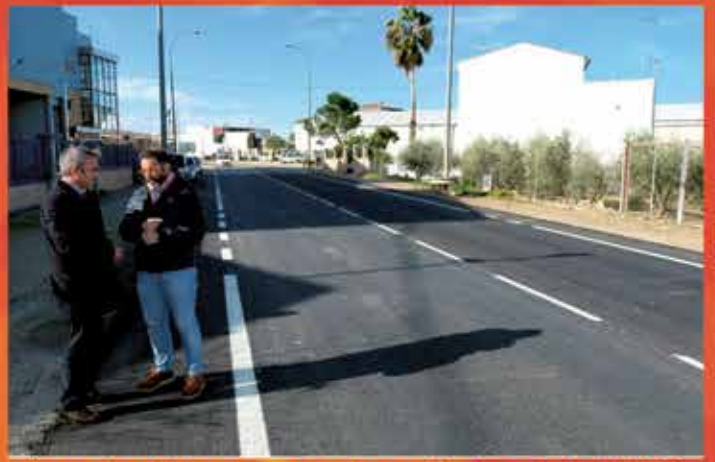
Arreglo del tramo con desperfectos de la A6000 que une Mengíbar con Villargordo
