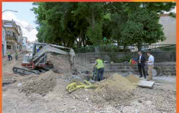
Renovación integral de calzada, acerado y saneamiento de la Avenida Pretel de Gámez
