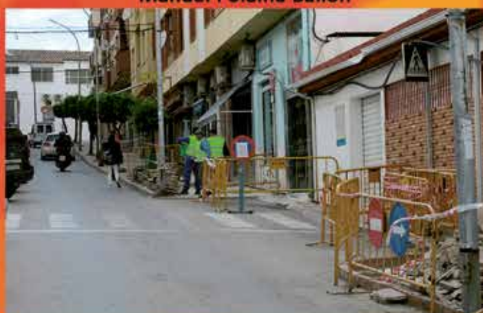
Obras de las nuevas canalizaciones de la Calle Real
