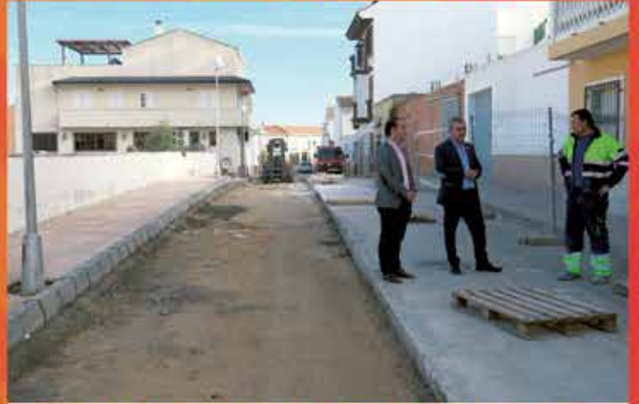
Arreglo de la calle Pablo Ruiz Picasso con las obras del muro del centro de salud
