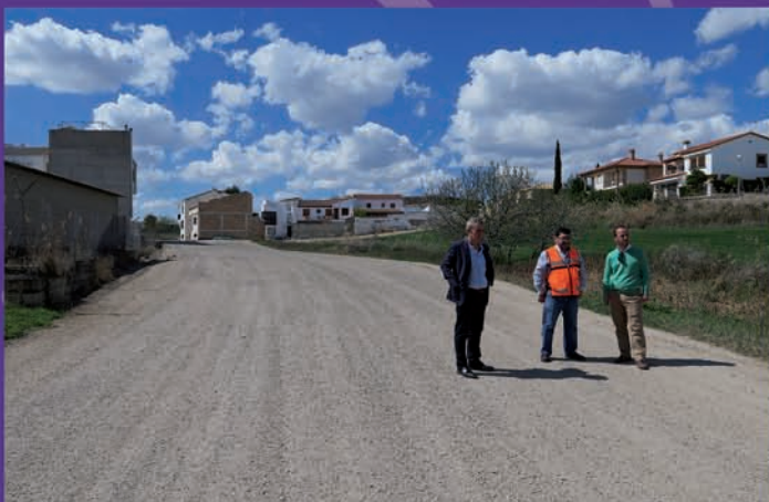
Arreglo calle Arroyo
