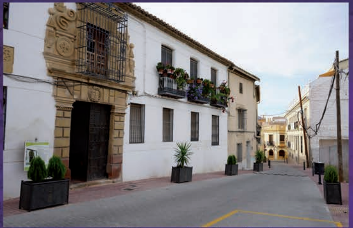
Renovación integral de la calle Jaén
