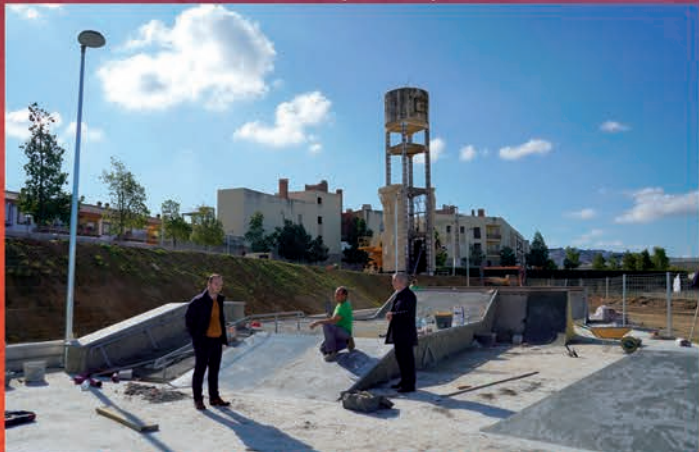
Construcción Parque Multiaventuras
