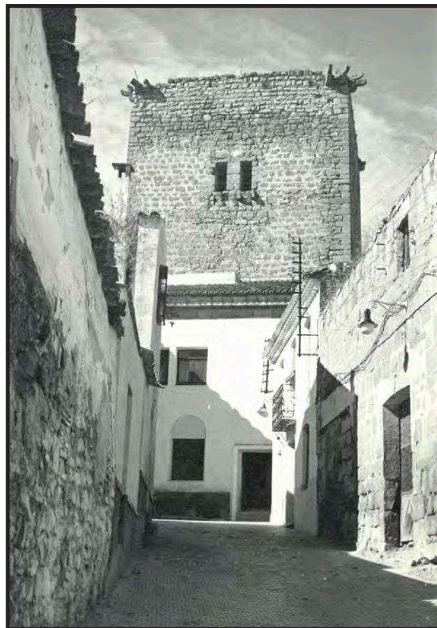
Calle "Pósito". A la derecha puede apreciarse la fachada de la antigua Plaza de Abastos.
