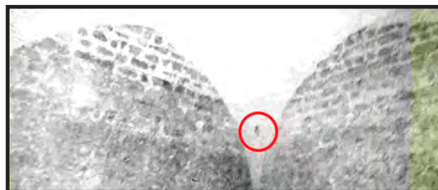
Atanores visibles en la pechina de la bóveda de la planta baja. Foto M. Ruiz Calvente, 82.
