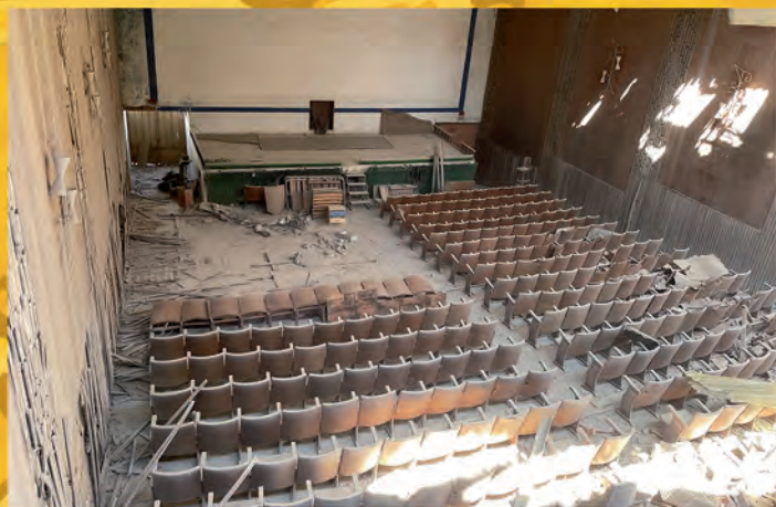
Demolición del Cine Avenida
