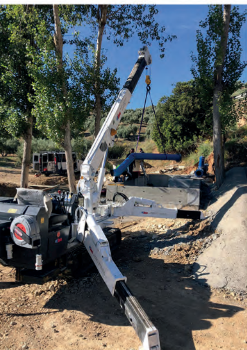
INSTALACIÓN DE CALDERERÍA PARA CONDICIONES DE AGUA POTABLE CON NUESTROS MEDIOS
