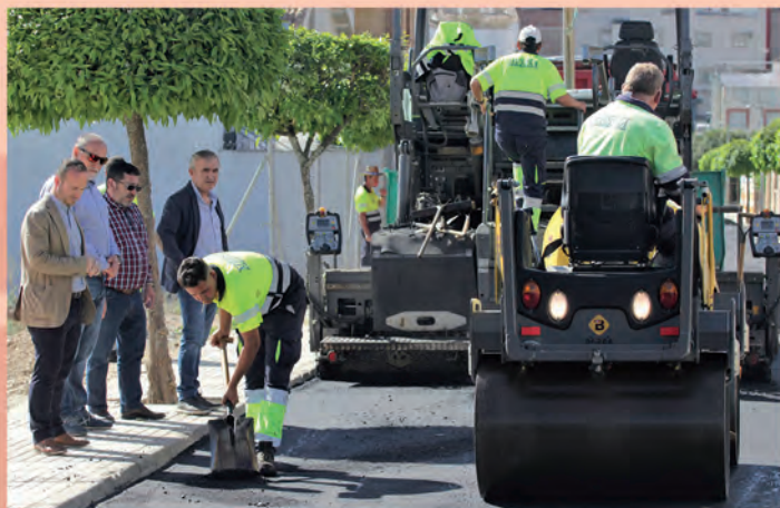
ASFALTO DE CALLES
