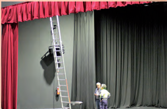
INSTALACIÓN DEL TELÓN EN EL AUDITORIO MUNICIPAL
