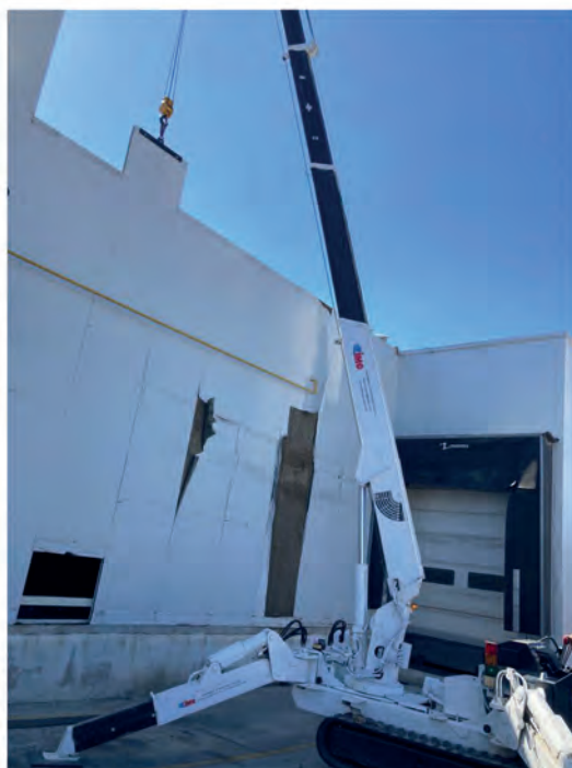
MONTAJE DE CERRAMIENTO Y DE PANELES
