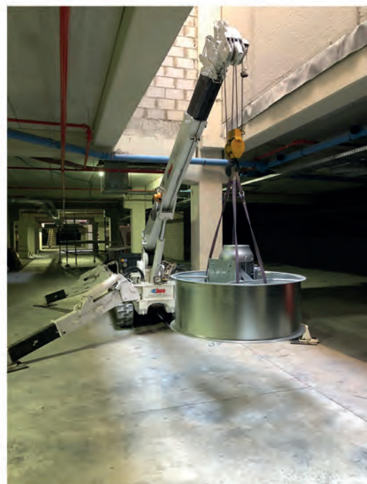
MONTAJES DE TURBINAS EN EL JAÉN PLAZA
