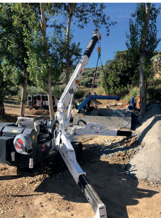
INSTALACIÓN DE CALDERERÍA PARA CONDICIONES DE AGUA POTABLE CON NUESTROS MEDIOS
