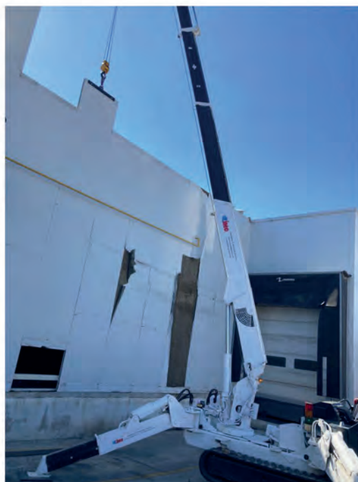
MONTAJE DE CERRAMIENTO Y DE PANELES
