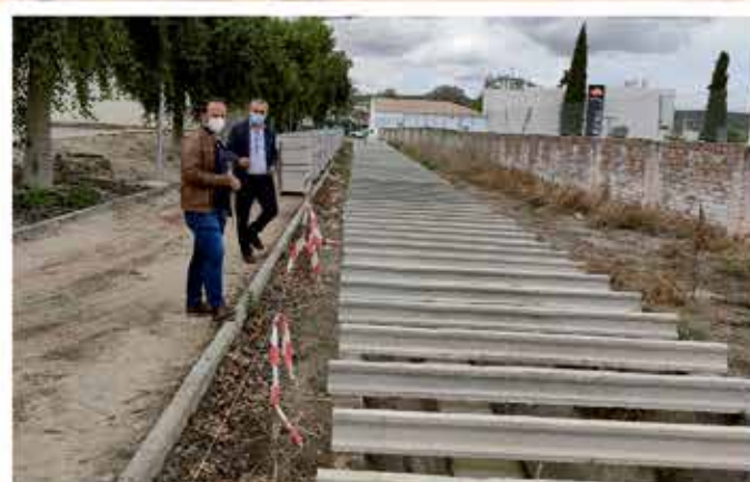
Obras de construcción de una vía verde en el canal
