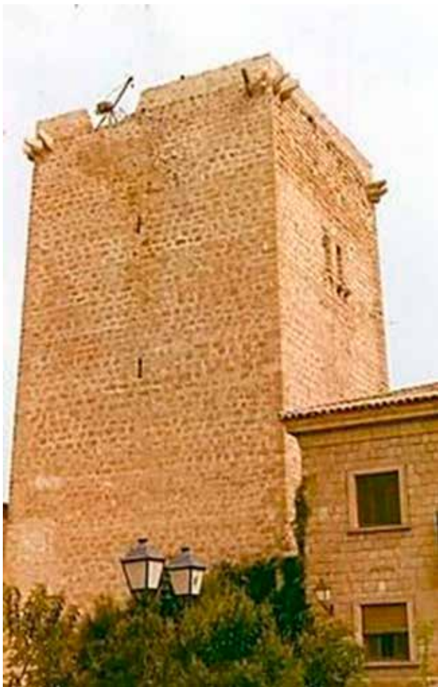
Trabajos de reparación del “desmoche” medieval y reconstrucción del parapeto y ménsulas de los matacanes de la terraza en la restauración y consolidación de la torre de 1982, según proyecto de la arquitecta A. Iglesias González.
