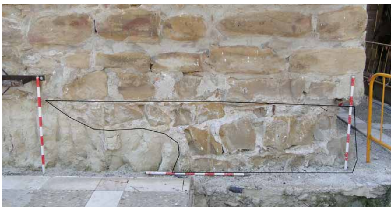
Cimentación del posible torreón islámico en el lateral Norte de la Torre del Homenaje.
