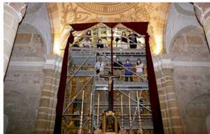
Arreglo del arco de San Pedro Apóstol
