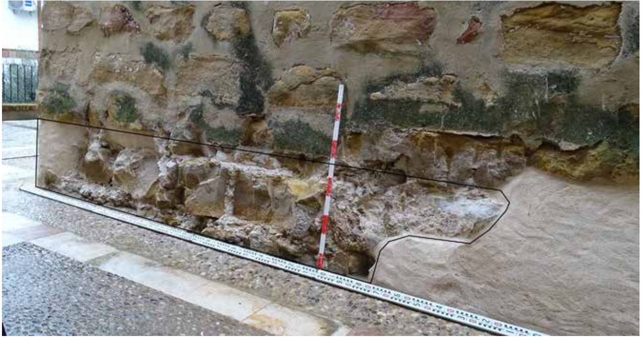
Cimentación del posible torreón islámico en el lateral Oeste de la Torre del Homenaje.
