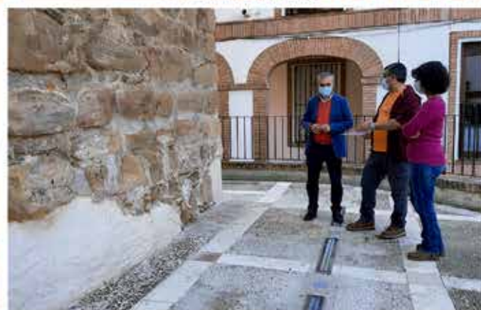
Arreglo de la base de la Torre del Homenaje y trabajos arqueológicos
