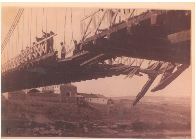
El Puente Colgado, que desapareció en 1930, a raíz de un accidente por el hundimiento de un camión cargado de toros lidia.
