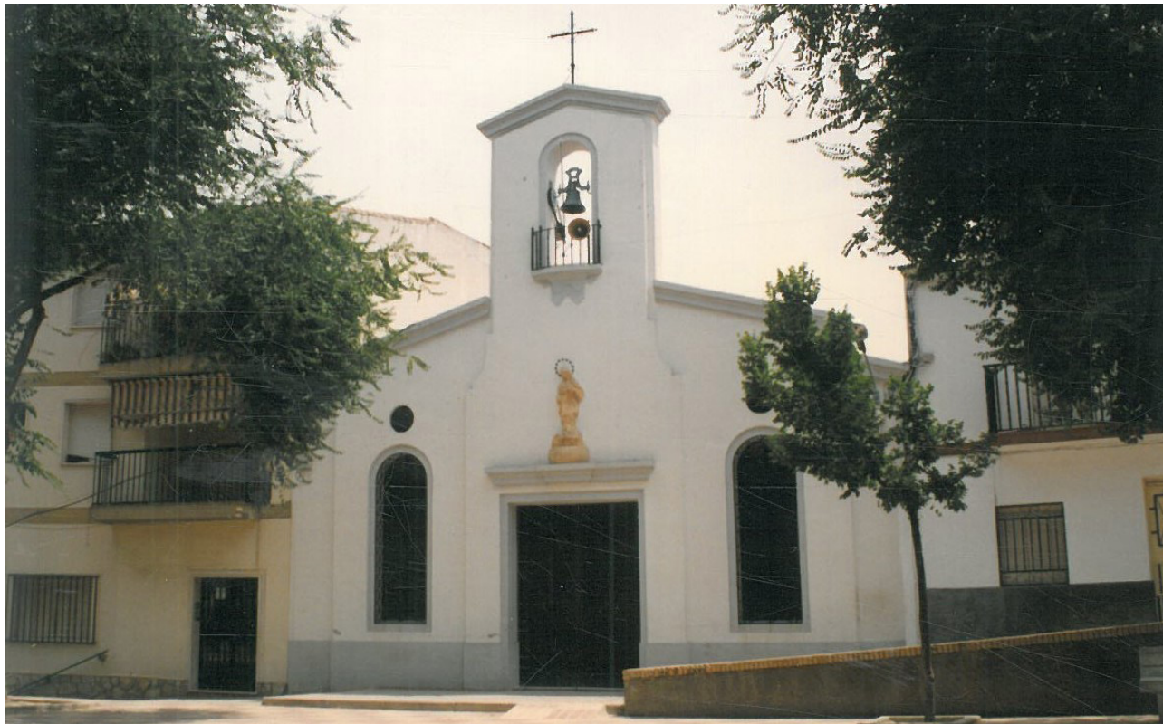
Fachada de la iglesia de la Inmaculada antes de la reforma.
