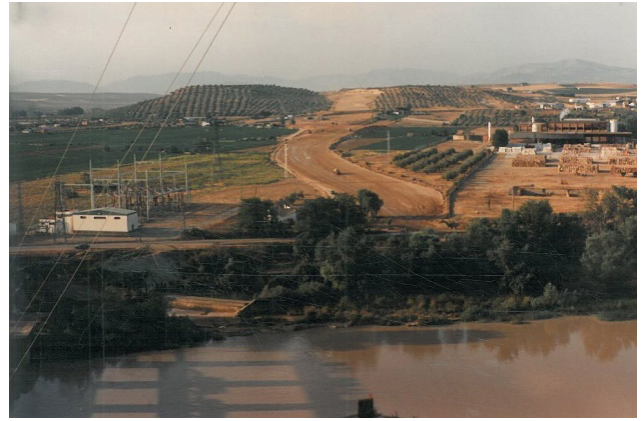
Obras de la autovía en la zona de "La Vega". Agosto 1994
