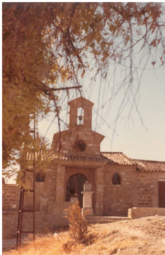
Verano 1981. Ermita del Señor de las Lluvias que se demolió para ser reconstruida por amenaza de ruina.
