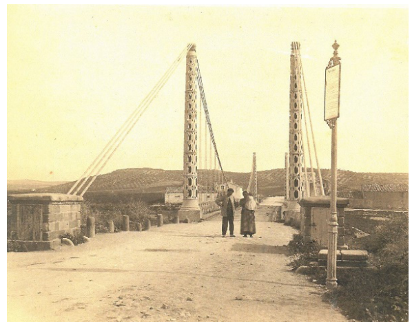
Un monumento bello de Mengíbar: el "Puente Colgado".
