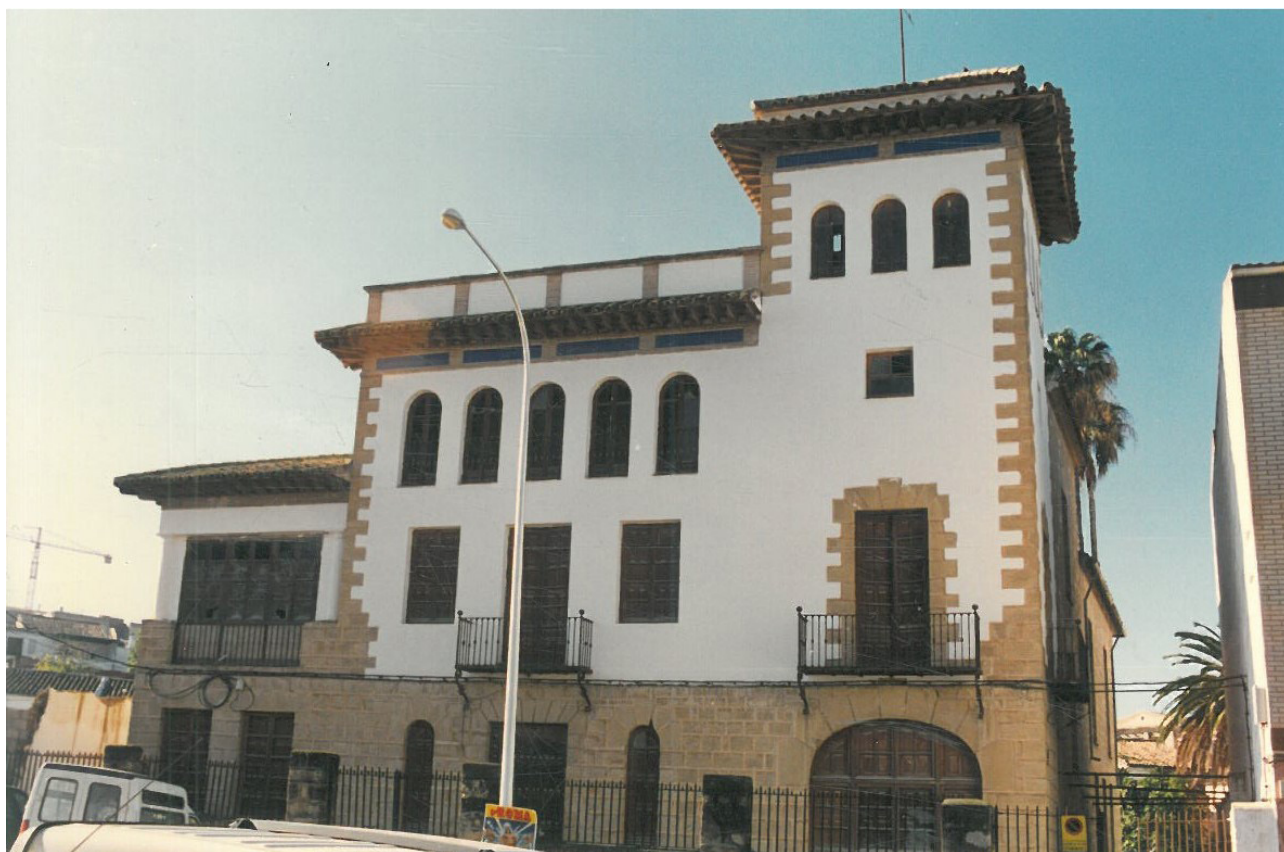
Casa de Codes, que necesita una seria restauración interior.
