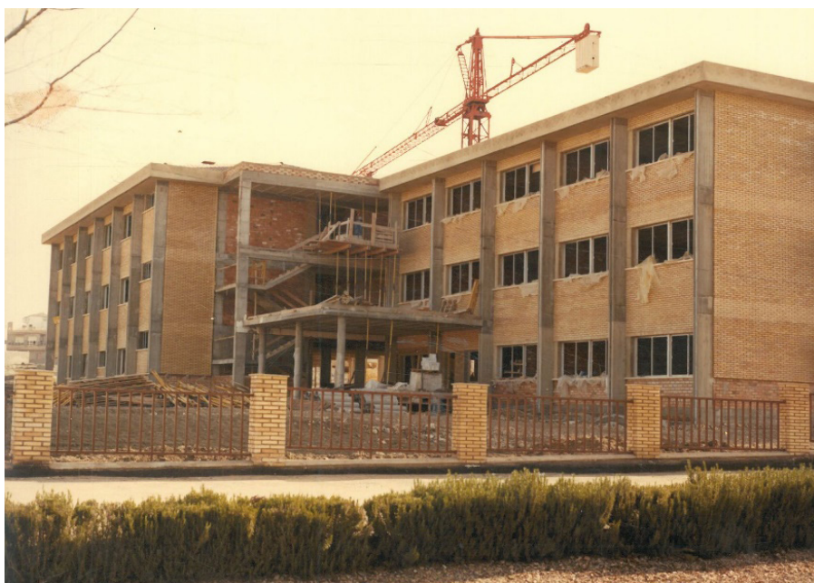
El Instituto Albariza en obras. Año 1983.
