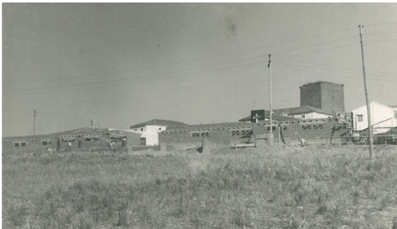
Construcción del colegio "Manuel de la Chica. Años 60.
