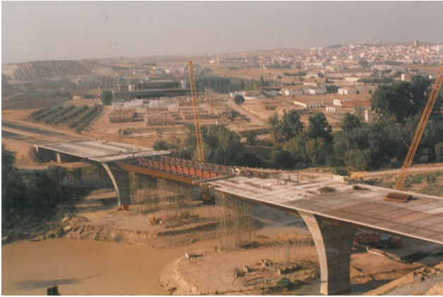
Construcción del puente de la autovía. Agosto 1995
