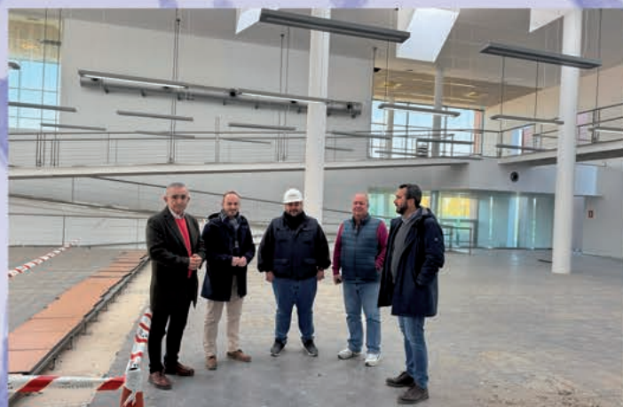
ADECUACIÓN DE LA NAVE EN GEOLIT
