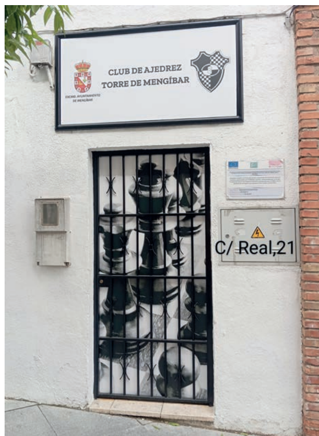
Fachada de la sede
