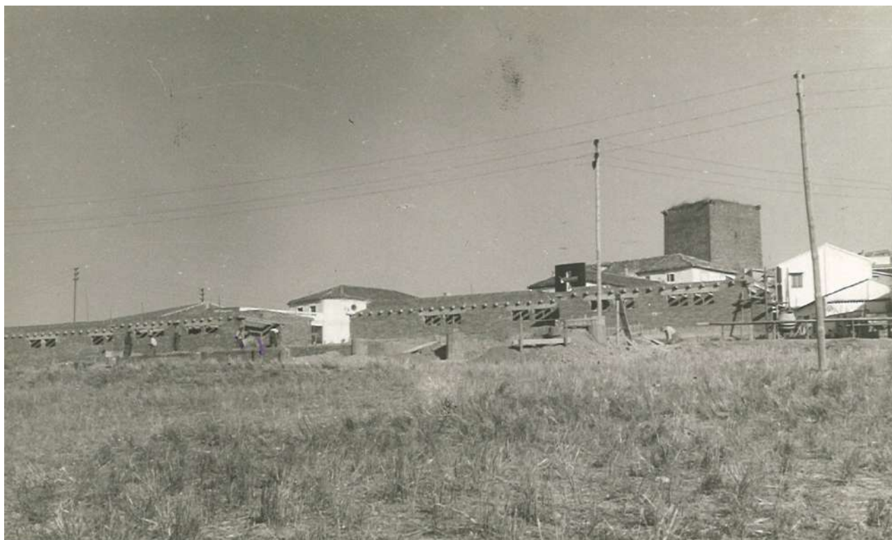
Obras de construcción del Grupo Escolar "Manuel de la Chica" en el año 1960. El colegio se inaugura en 1964.
