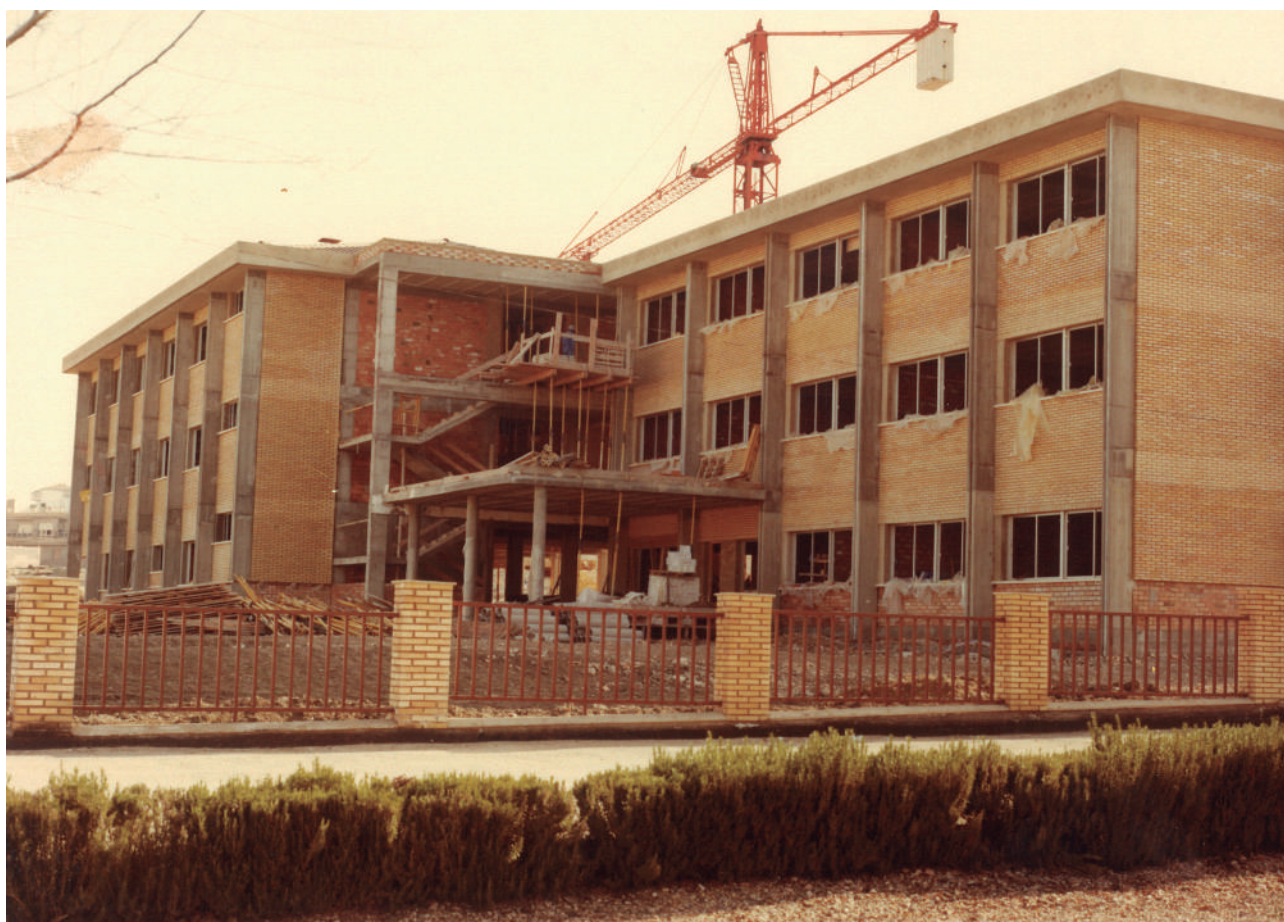
El instituto "Albariza" en obras. 1983.
