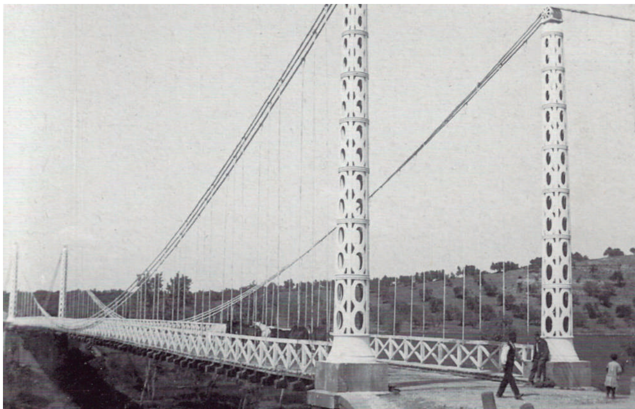
El bellissimo y desaparecido “Puente de Alambre” sobre el Guadalquivir
