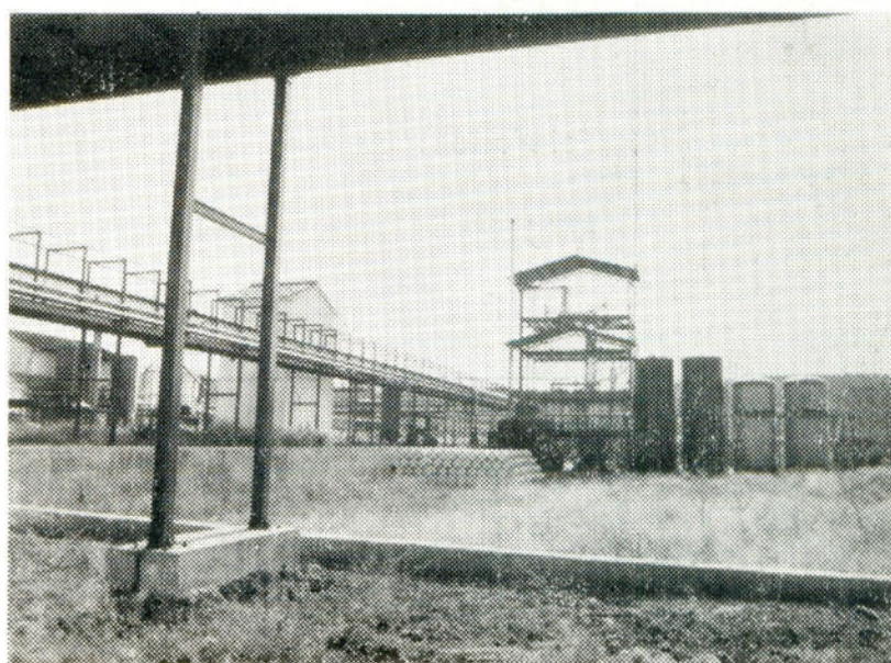
Nueva planta hidrógeno en la Fábrica D.E.R.I.V.A.N.
