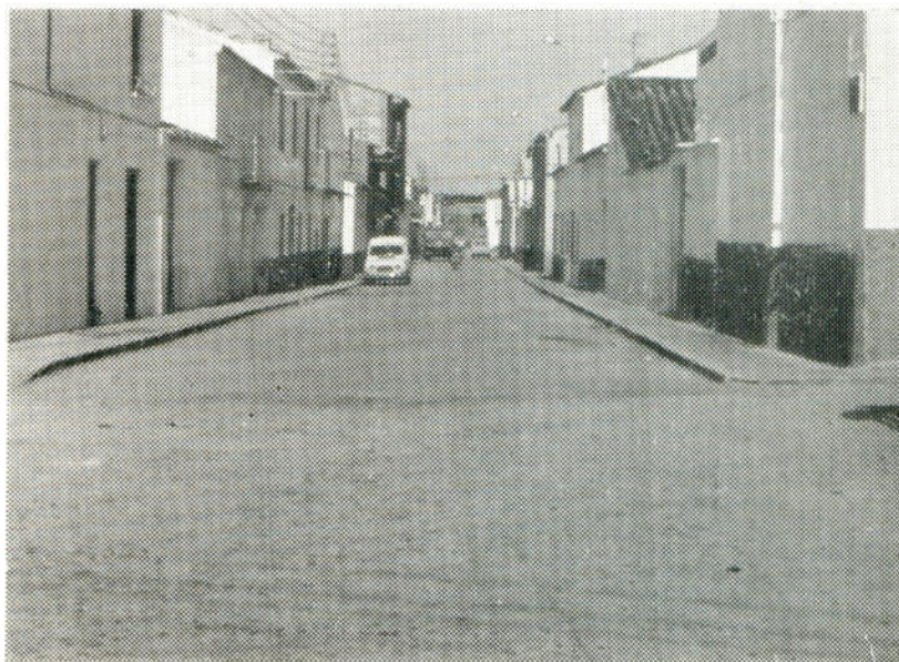
Nueva pavimentación calle General Reding
