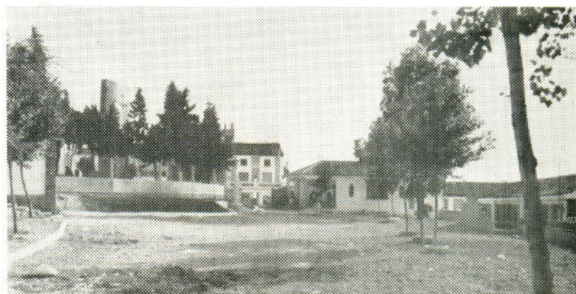
Obras de renovación en el Parque Infantil Don Juan de la Rosa Mateos
