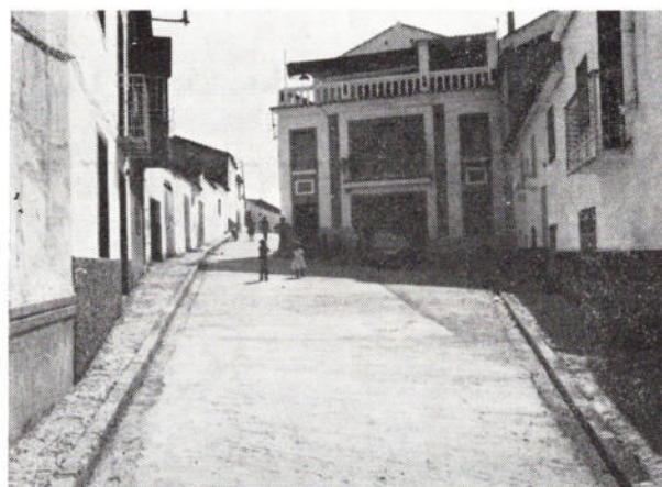
Calle García Pintado. Esta obra se está realizando con fondos de Empleo Comunitario y aportaciones modestas por parte del vecindario.
