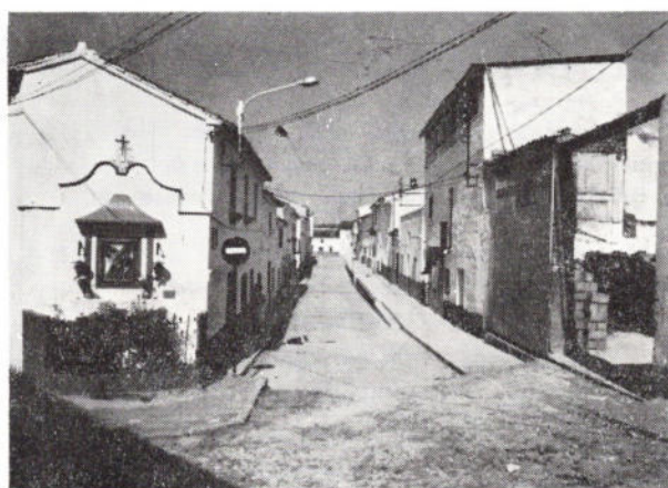
Calle Moral Fernández. Obra realizada por Acción Comunitaria y aportaciones vecinales.
