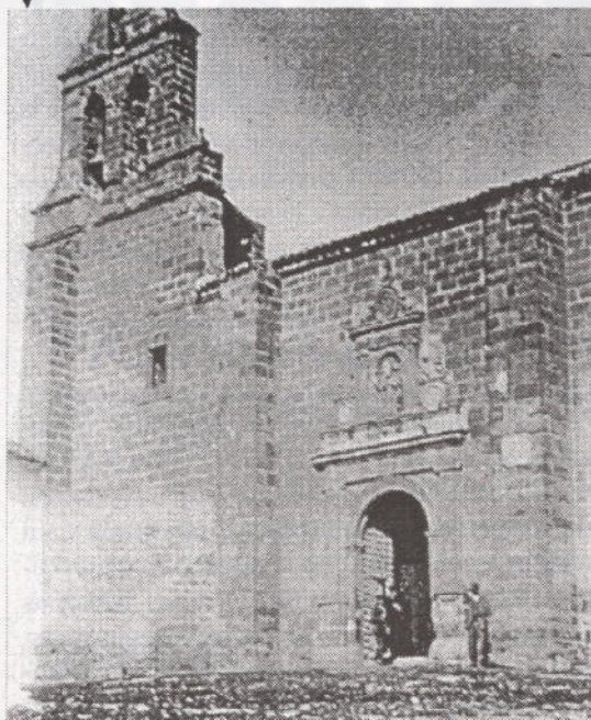
Foto n.º 406. Fachada principal de la iglesia parroquial de San Pedro Apóstol en 1913. Destaca el piso de la plaza y el actual callejón, cerrado por un muro.
