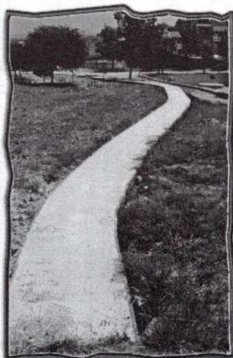
Canalización Fuente Redonda
