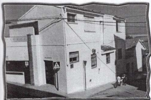
Instalación del Nuevo Juzgado
