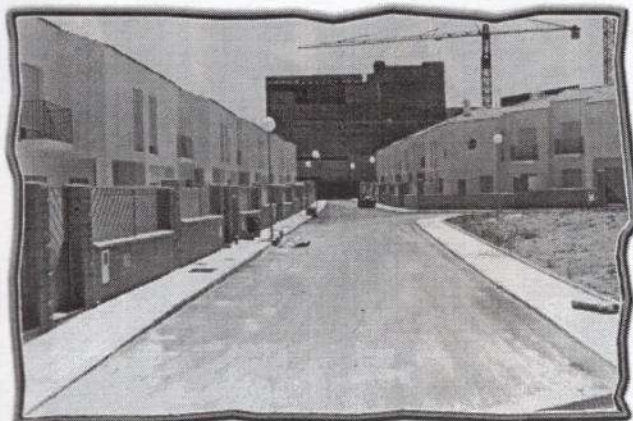
Terminación 63 viviendas y Urbanización
