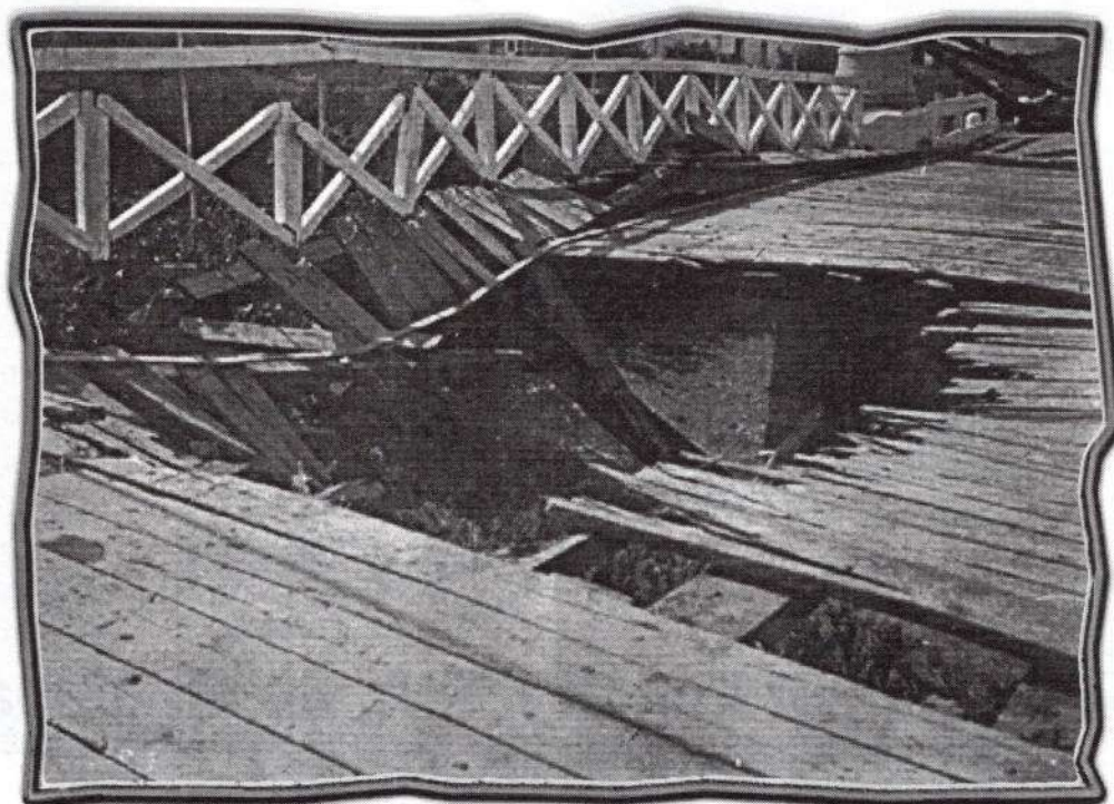
Otra vista del piso del Puente.
