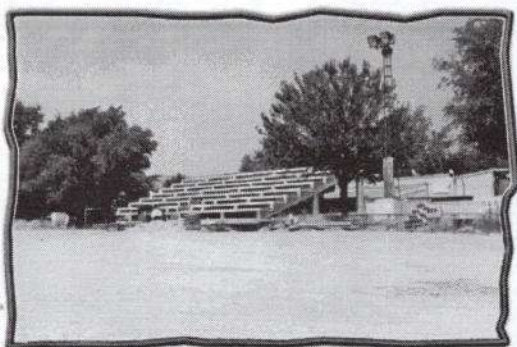
Realización de gradas Campo de Fútbol
