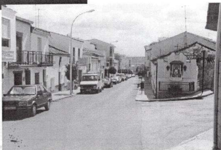
Pavimentación C/. Real Plan de Obras 2001
