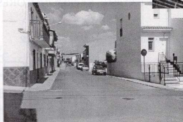
Pavimentación C/. San Juan Plan de Obras 2001
