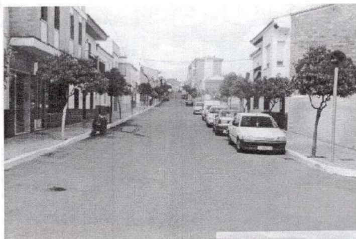
Pavimentación C/. Corredera Plan de Obras 2001
