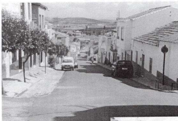
Pavimentación C/. Real Plan de Obras 2001
