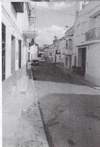
Pavimentación C/. Jaén Plan de Obras 2001
