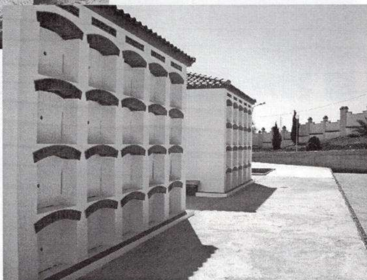
Obras en el Cementerio
