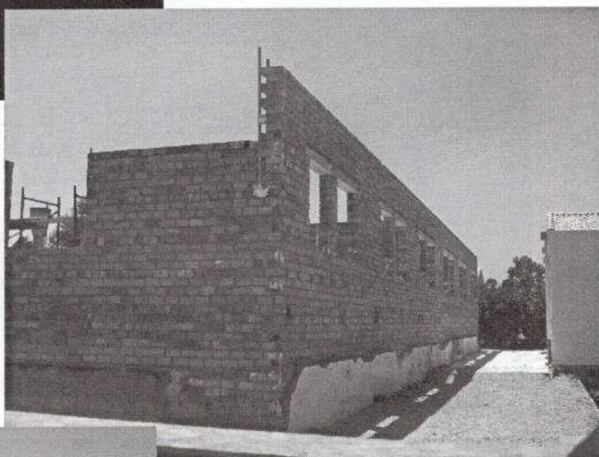
Construcción de Naves en Depuradora Escuela Taller
