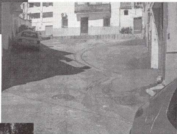
Pavimentación C/. Pintor Zabaleta (en proyecto)
