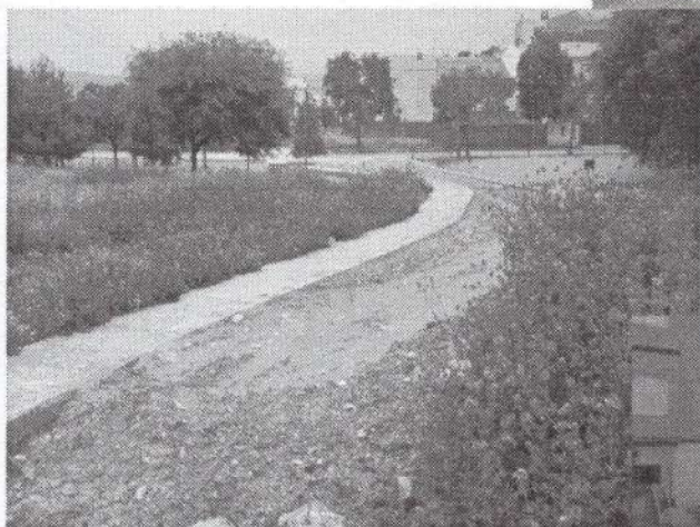
AEPSA. Canalización Arroyo Fuente Redondo
