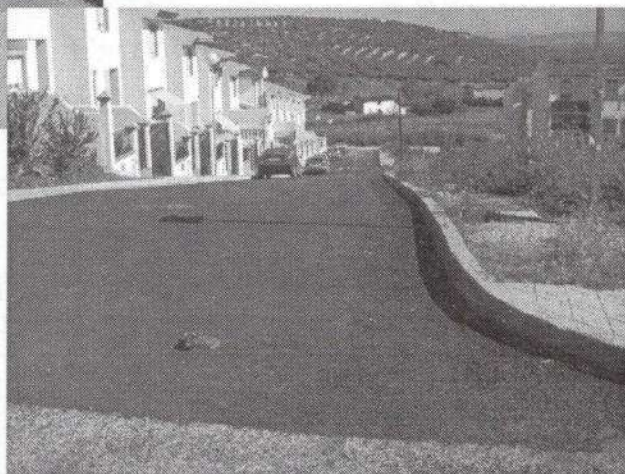
Pavimentación C/. Naranjo
