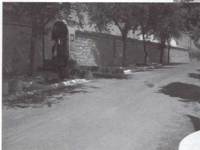
Cementerio. Obras y reformas
