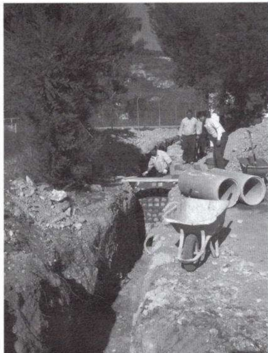
AEPSA. Construcción de Nave y Saneamientos
