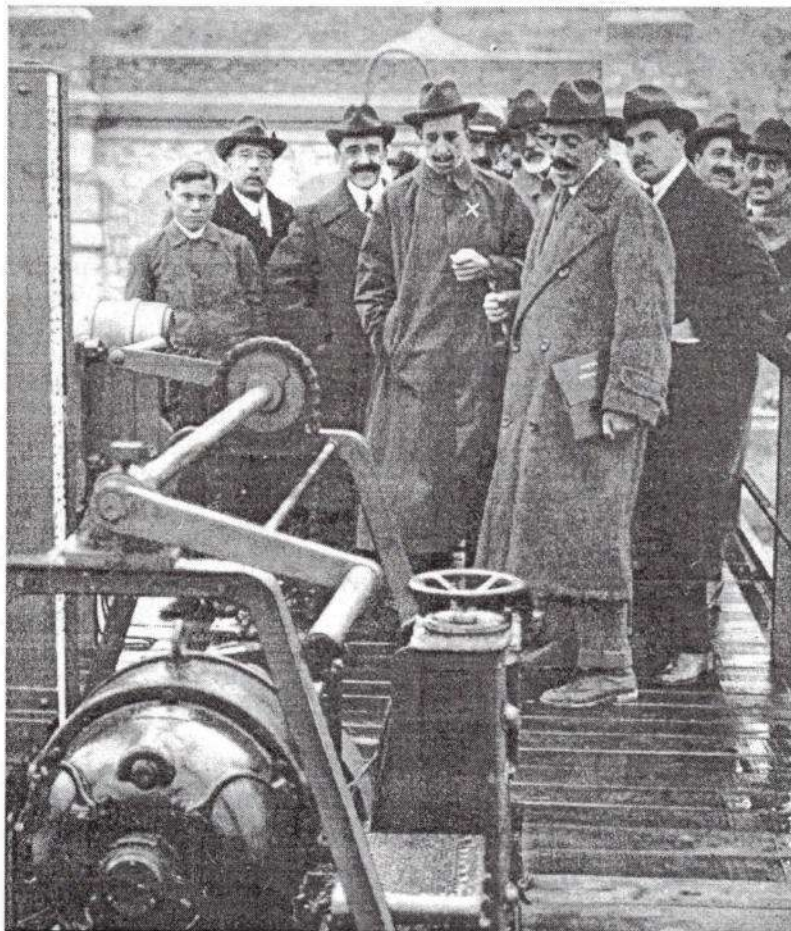
D. Alfonso XIII, inaugura la Central Hidroeléctrica de Mengíbar, de la compañía MENGEMOR, el 20 de Noviembre de 1916.
