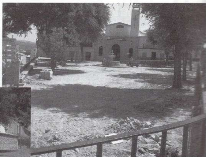
Plaza de la Libertad. Pavimentación (Prodecan)
