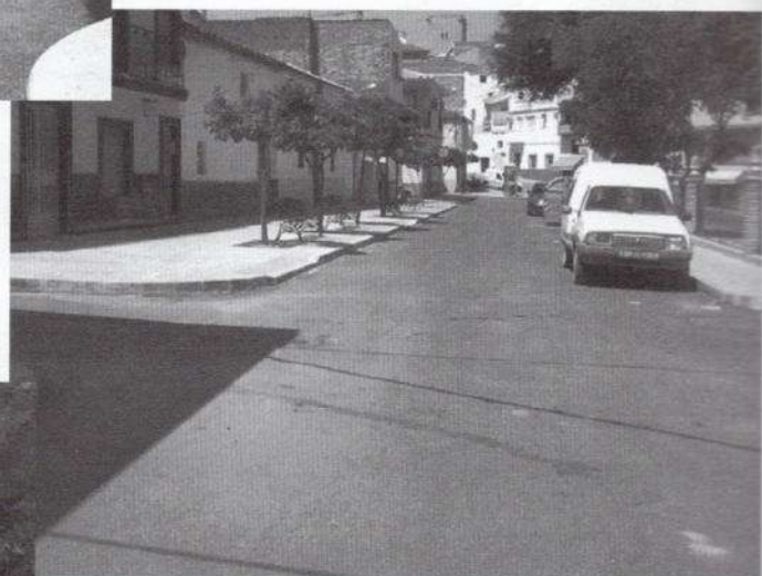
C/. General Reding. 2 a fase. Pavimentación
