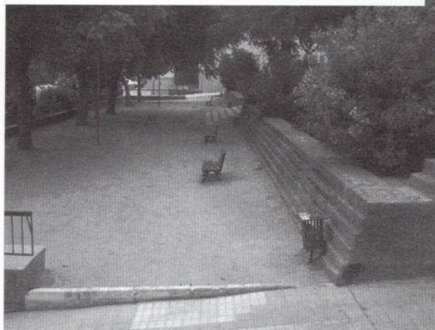
Proyecto pavimentación Plaza San Isidro
